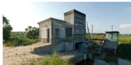
Fig.14: Consorzio Cà Gamba impianto Jesolo
