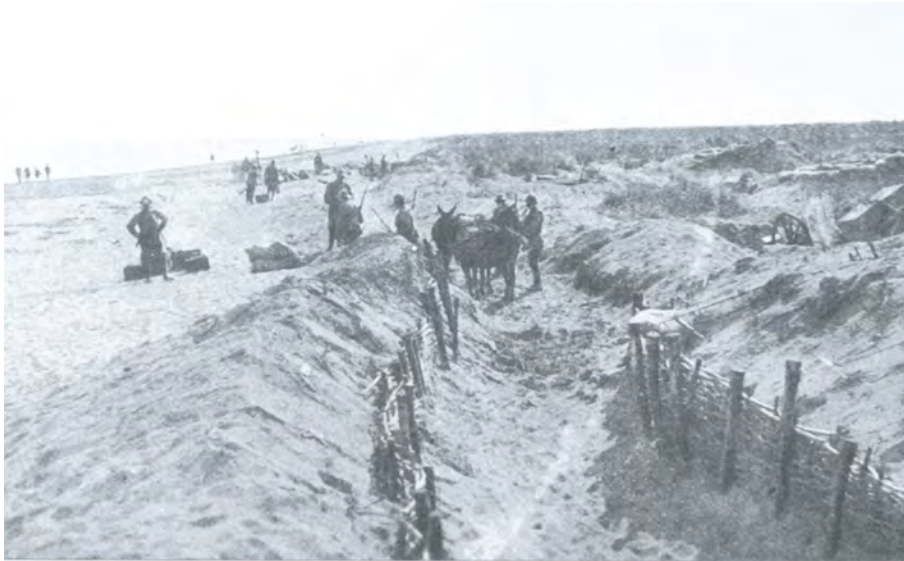
Fig.15: Lavori di trinceramento lungo la spiaggia di Cortellazzo
