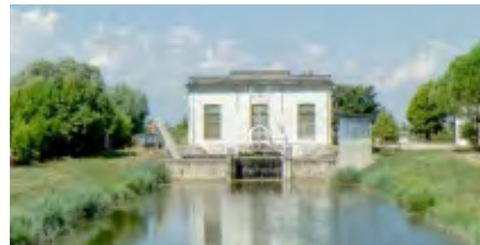
Fig.15: Consorzio Cà Gamba impianto Cortellazzo
