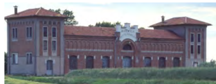
Fig.13: Consorzio Sette Sorelle
