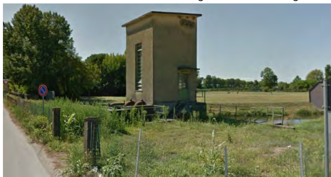
Fig. 19: Stazione di pompaggio
