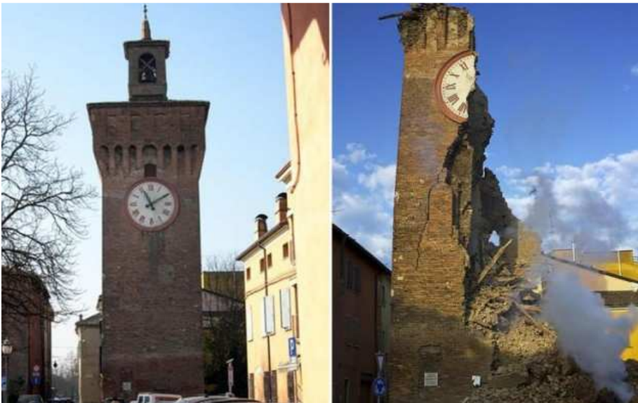
Figura 1.1. Quello che resta del Palazzo del Governo a L'Aquila dopo il terremoto Figura 1.2. Il campanile di Finale Emilia, prima e dopo la prima scossa (fonte web)
