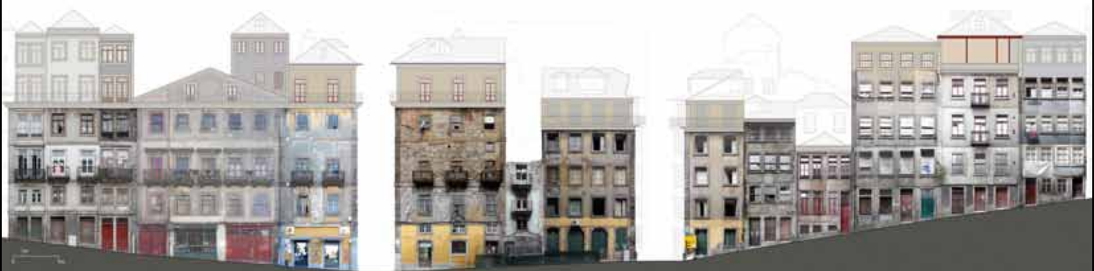
Fonte: Rua de São João / Fonte: Rua do Cláudio Froyel Pereira / Fonte: Rua dos Mercadores
