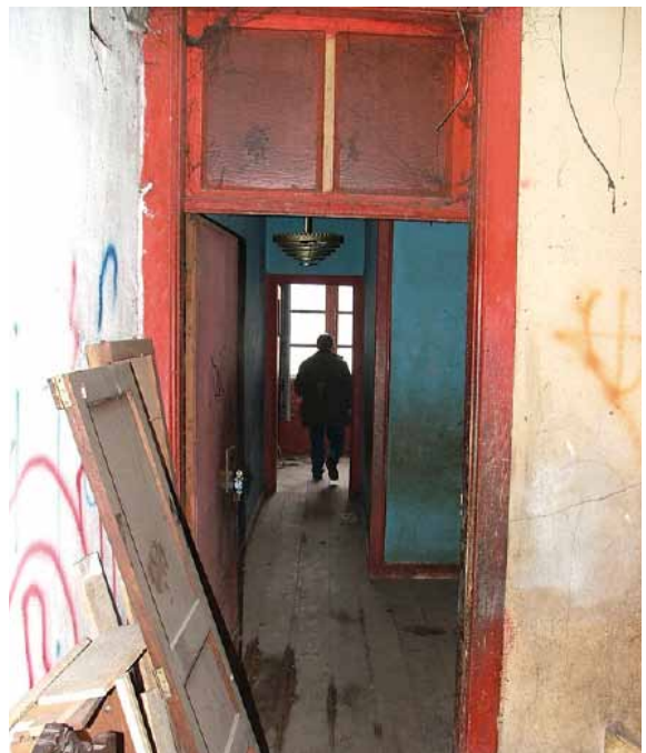
81- P7, piano terzo, lato rua de São João
