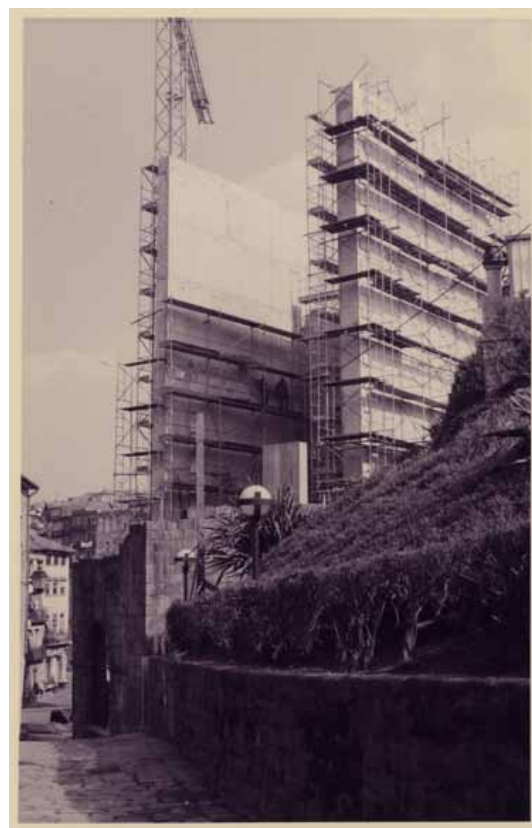
9- Paço do Conselho. Fase di cantiere
