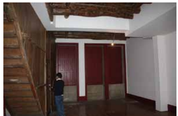
84- P6, piano primo, lato rua dos Mercadores
