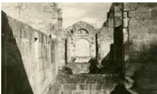
1- Convento di Santa Marinha da Costa. Il connettivo al primo piano prima dell'intervento.
