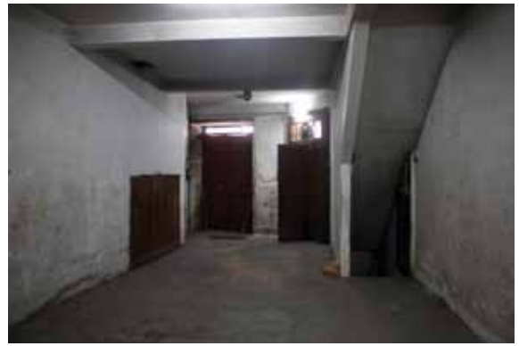
75- P8, piano terra, lato rua de São João
