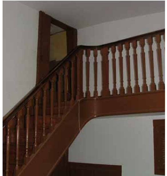
73- P9, piano quinto, lato rua dos Mercadores
