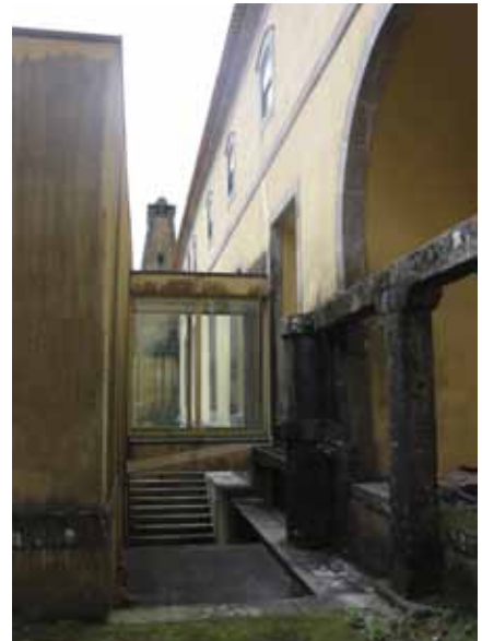
6- Scuola di Agraria. Passaggio tra l'ex monastero e il nuovo auditorium
