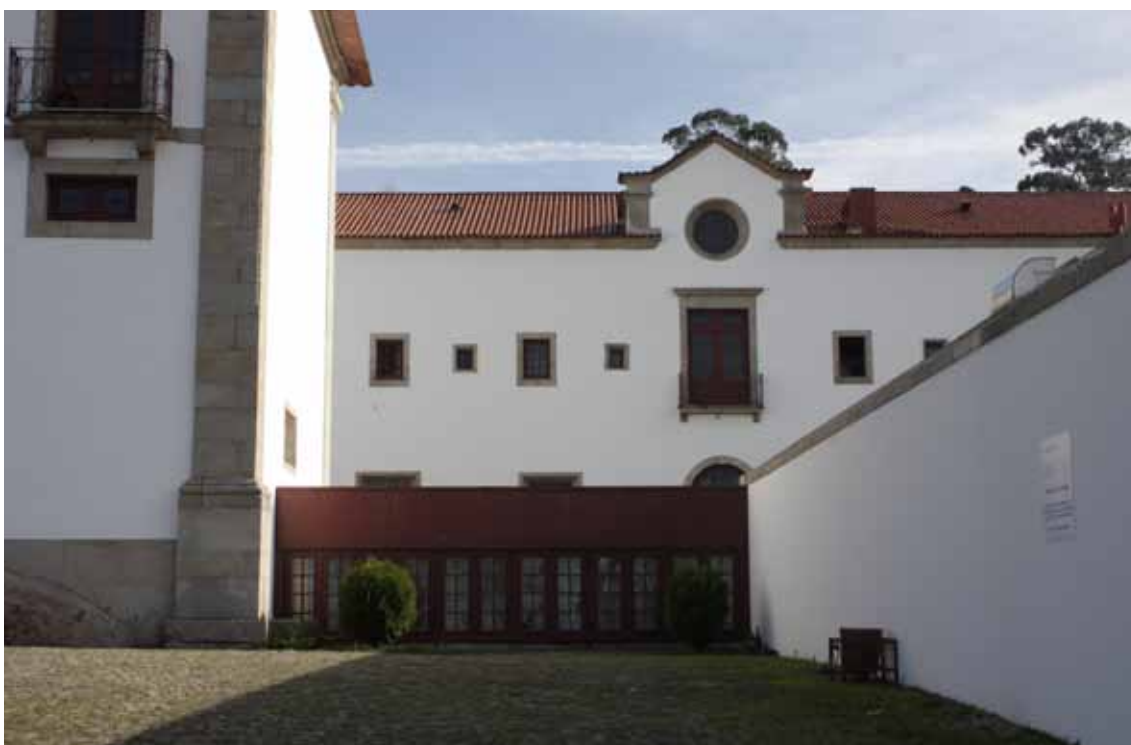
4- Pousada di Santa Marinha da Costa. Passaggio tra la preesistenza e il nuovo annesso
