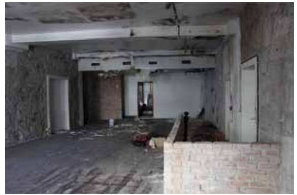
89- P4, piano primo, lato rua de São João
