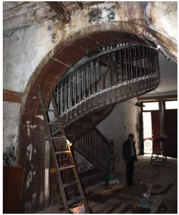
79- P7, piano terra, lato rua de São João
