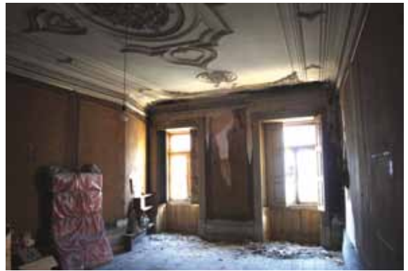
76- P8, piano terzo, lato rua de São João
