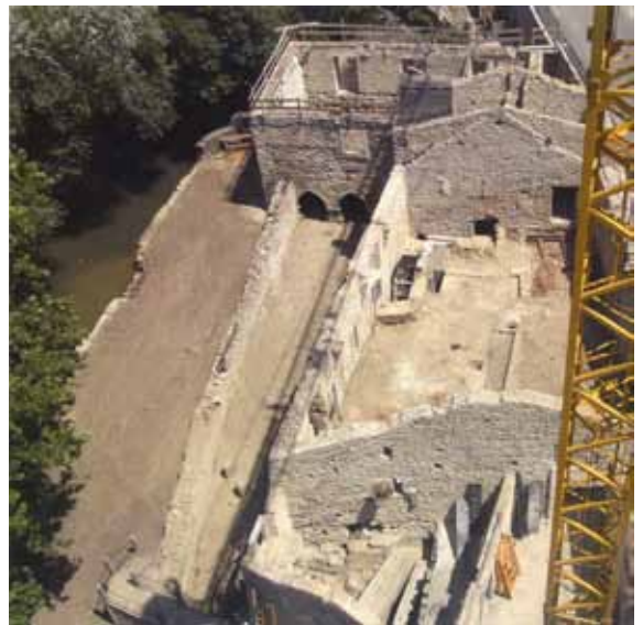
25- Moinho do Papel. Fase di cantiere
