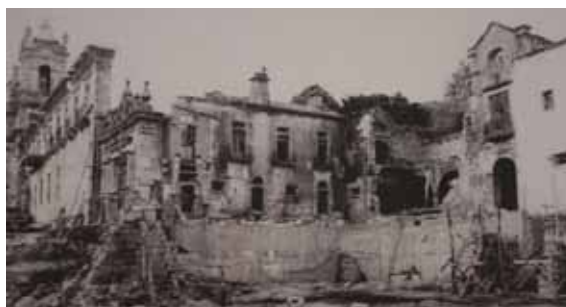
2- Convento di Santa Marinha da Costa. Fase di cantiere.
