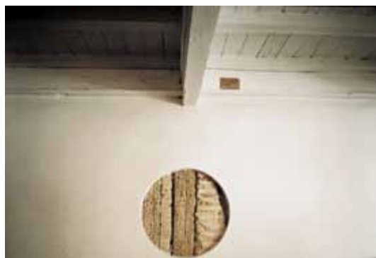
14- Guimarães. Casa di Rua Nova
