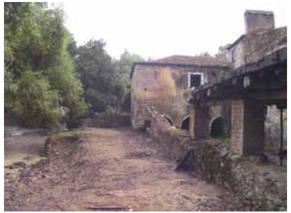
24- Moinho do Papel. Stato prima dell'intervento.
