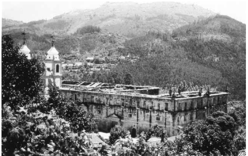
31- Santa Maria do Bouro. Il convento abbandonato di prima dell'intervento
