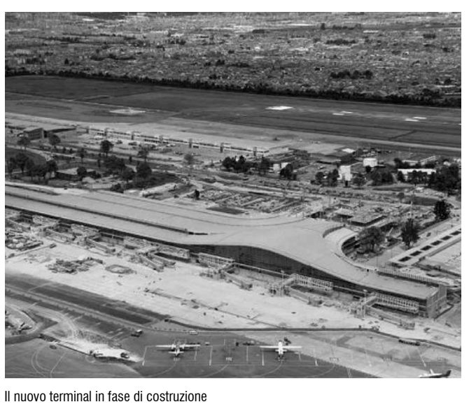
Il nuovo terminal in fase di costruzione
