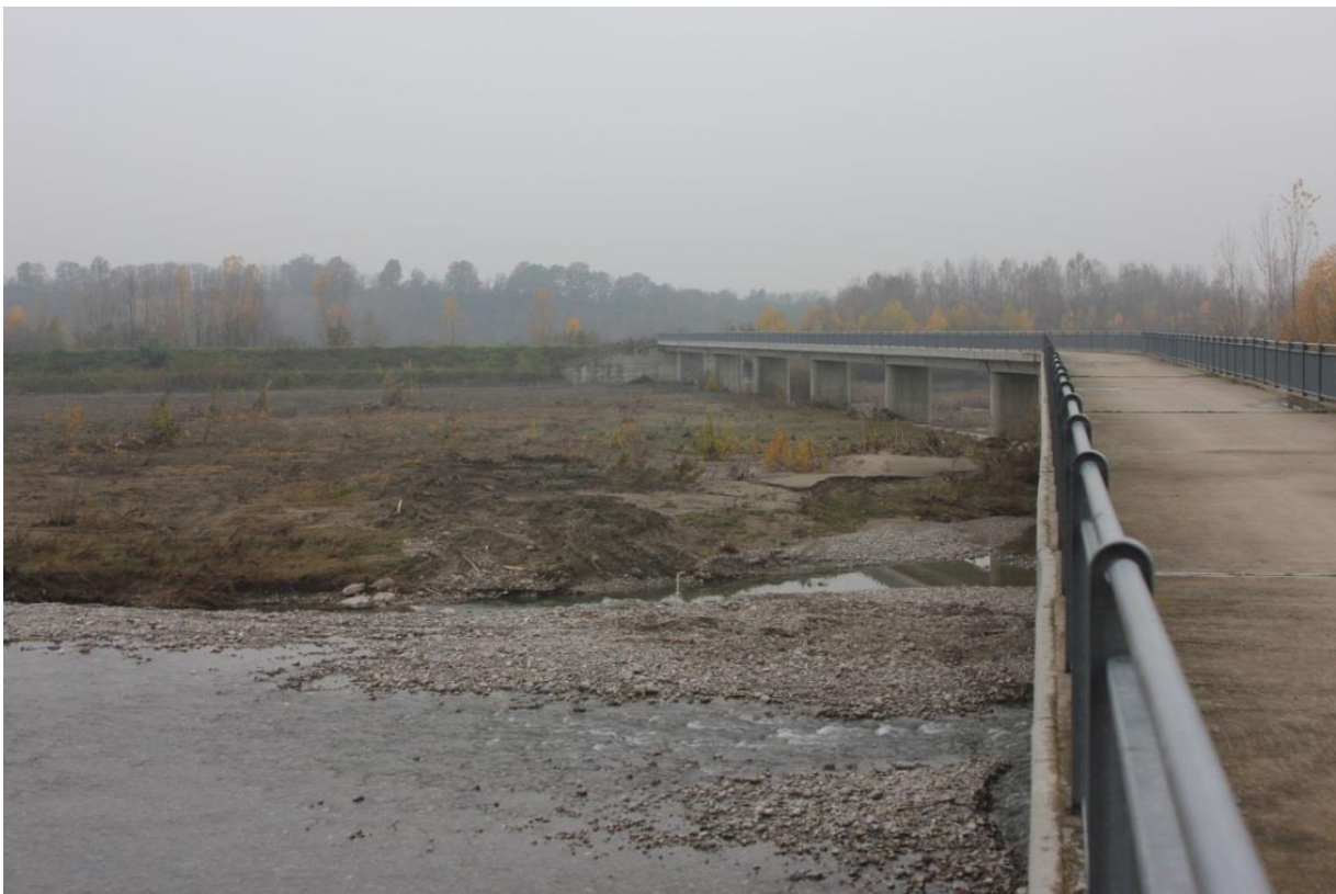
Figura 6.3.1.1 – Sistema di opere a presidio della Cassa di Espansione di monte, in particolare in lontananza si vede lo scarico di alimentazione alla cassa.
