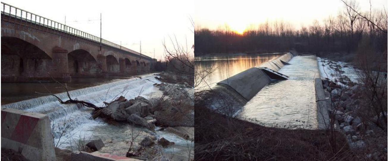
Figura A.4.1.2 – Immagini dell’Enza nel tratto compreso tra le sezioni 260-270: si vedono diversi salti di fondo sia nell’immagine a sinistra che in quella a destra.
