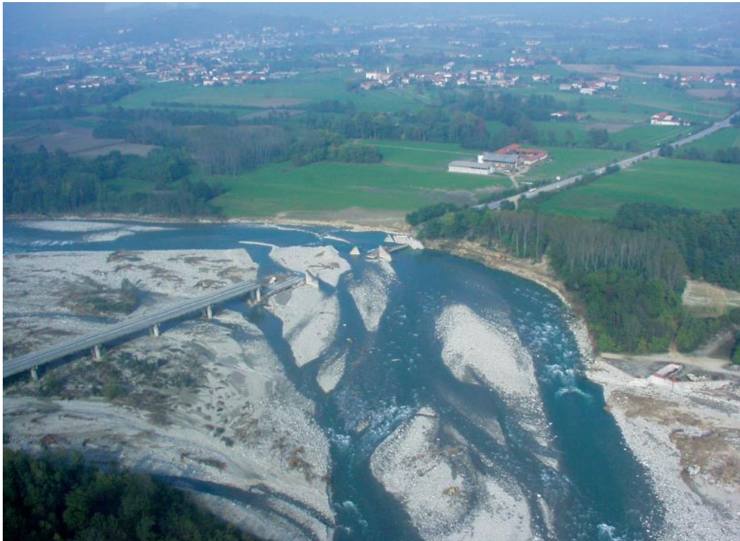
Figura 2.1.3 - Crollo di un ponte stradale sul Fiume Po.
