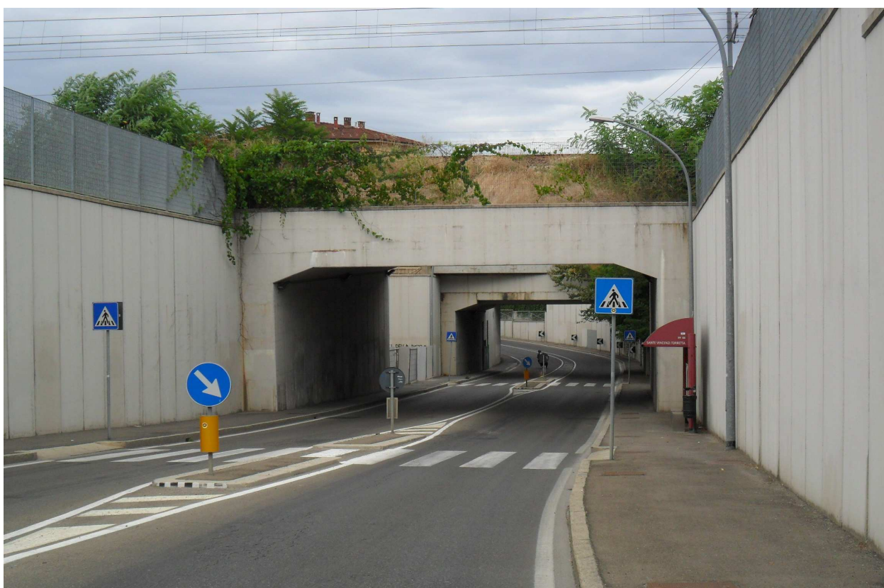
foto 12 – nuovo sottopasso via Henghel
