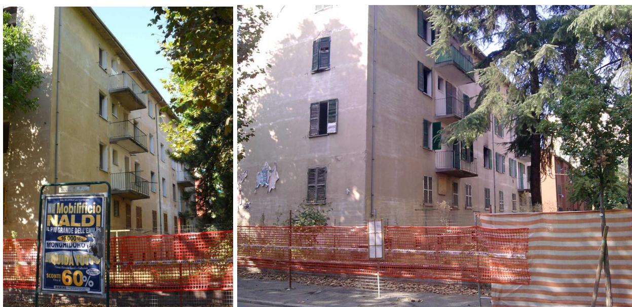
foto 25 - 26 - Zona di cantiere via Beroaldo
