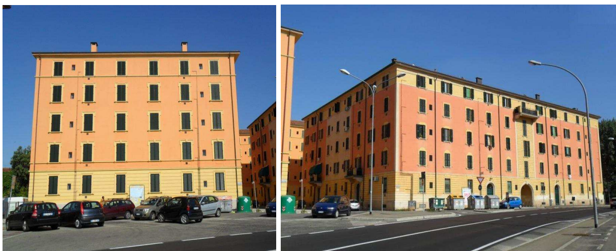
foto 9 - foto 10 - Immobili in via Rimesse dopo gli interventi di riqualificazione
