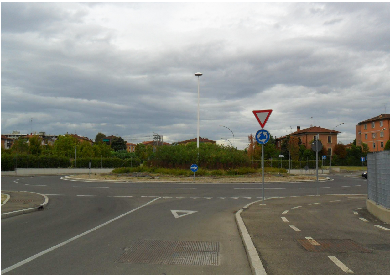
Foto 13 – nuova rotonda via Rimesse - v. Henghel - v.S.Vincenzi
