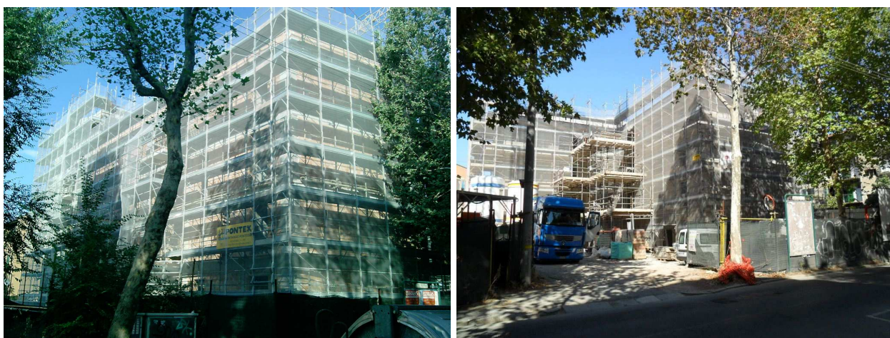
foto 27 - 28 - Zona di cantiere, nuove palazzine, via Beroaldo
