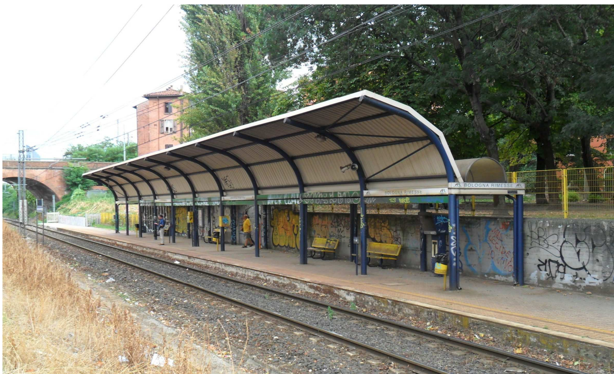
foto 11 – nuova fermata S.F.M. su via Rimesse
