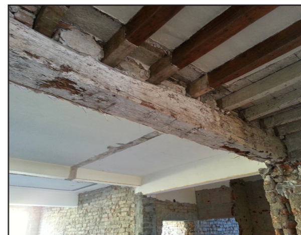
Figura 7.4.2.3.1.: Edificio III, piano secondo, solaio ligneo (fonte studio BBP ingegneria).
