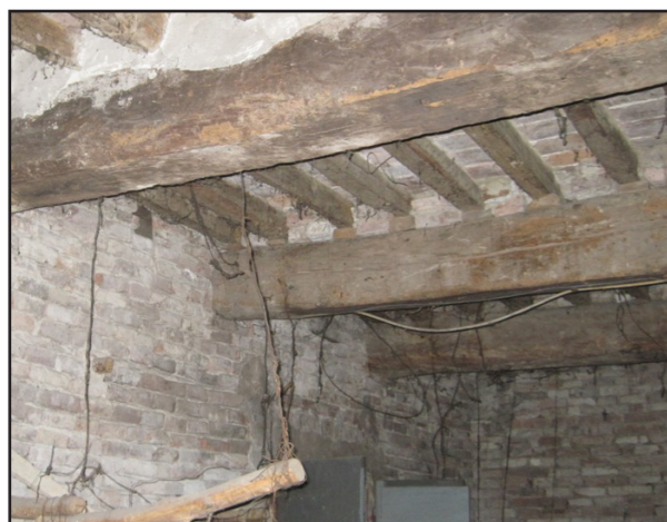
Figura 7.10.2.2.1.: Edificio X, piano primo, particolare del solaio.
