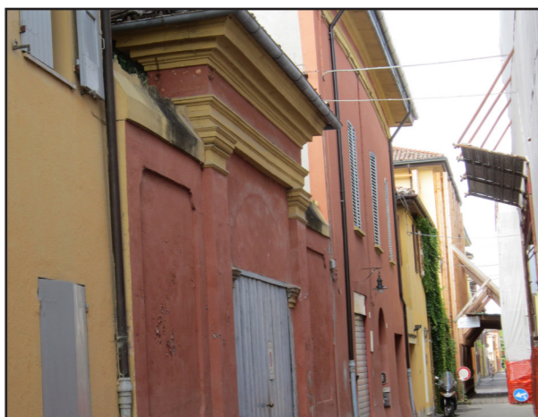
Figura 7.8.3.: Edificio VIII, particolare della recinzione.
