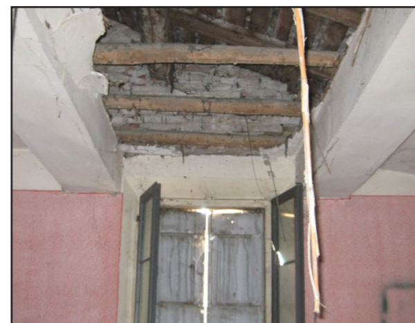
Figura 7.10.2.3.2.: Edificio X, copertura, particolare della copertura.
