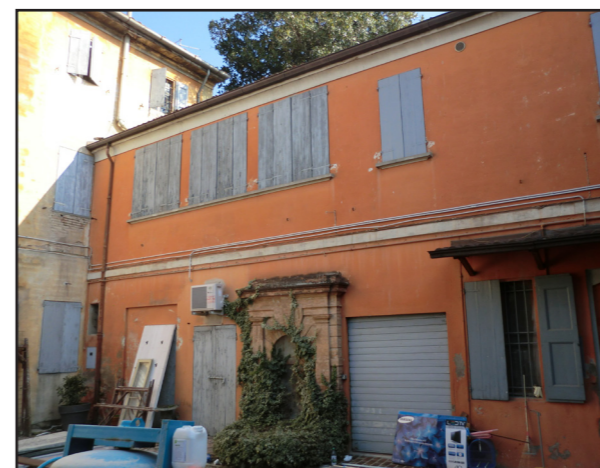
Figura 7.5.1.3.: Edificio IV, prospetto est sul cortile interno e fontana (fine XIX secolo).
