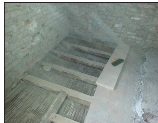
Figura 7.4.2.2.2.: Edificio III, piano primo, solaio ligneo (fonte studio BBP ingegneria).
