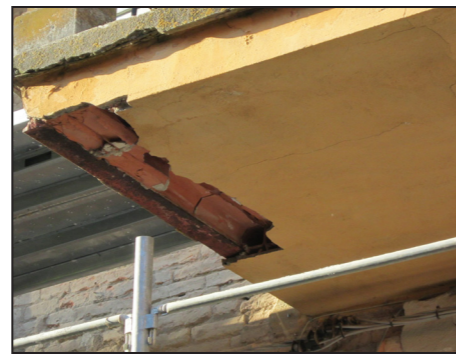
C. Particolare del balconcino.
