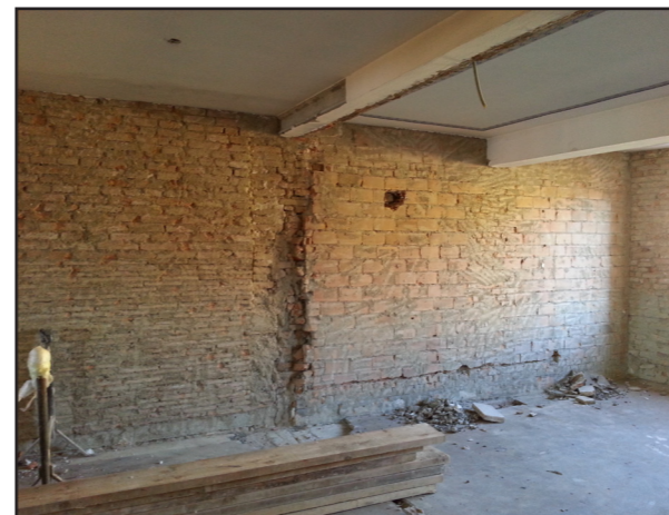
Figura 7.4.2.3.4.: Edificio III, piano secondo, paramento murario privo di ammorsamenti (fonte studio BBP ingegneria).
