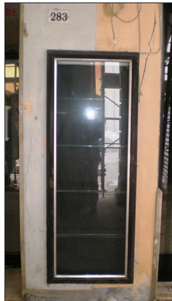
Figura 10.1.1.2.: Edificio I, portico, particolare delle lesioni a taglio.
