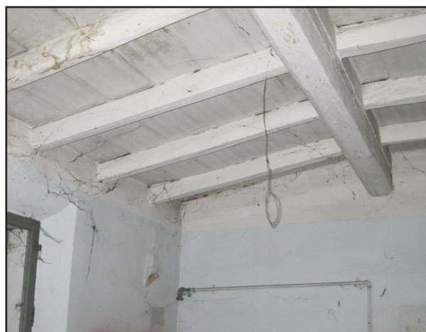
Figura 7.10.2.1.1.: Edificio X, piano terra, particolare del solaio ligneo con tavelle.
