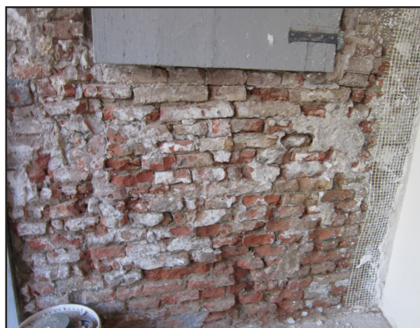
Figura 7.5.2.1.6.: Edificio IV, autorimesse e portico nell'ala sud, muratura.
