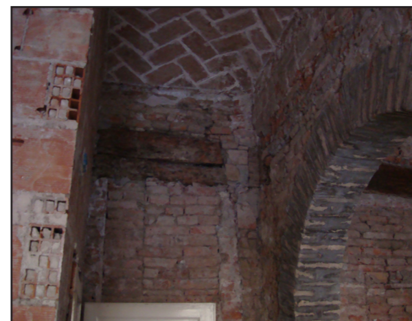
Figura 7.4.2.1.5.: Edificio III, piano terra, particolare murature (fonte studio BBP ingegneria).
