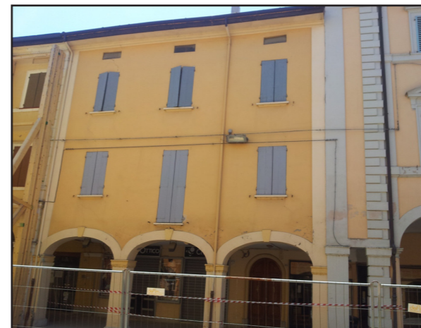
Figura 7.3.1.1.: Edificio II, prospetto principale su via Matteotti.
