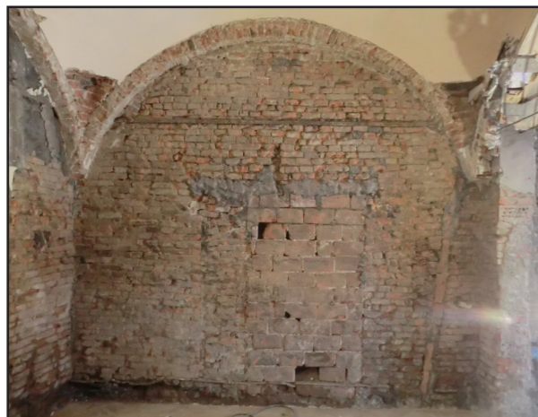
Figura 7.2.2.1.10.: Edificio I, negozio 1, particolare dell'arco tamponato.
