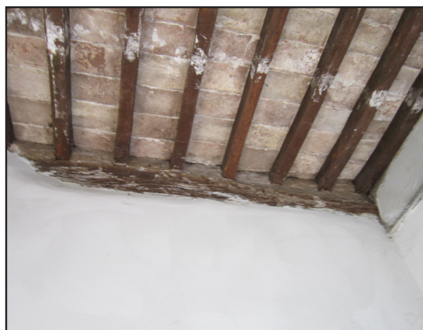
Figura 7.5.2.1.1.: Edificio IV, magazzino 1 nell'ala ovest, particolare del solaio ligneo.
