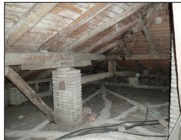
Figura 7.2.2.4.4.: Edificio I, sottotetto, particolare del cantonale.
