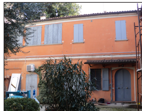
Figura 7.5.1.2.: Edificio IV, prospetto est sul cortile interno (della fine del XIX secolo).
