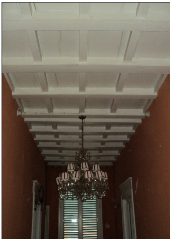
Figura 7.2.2.2.1.: Edificio I, appartamento 1, particolare del solaio finto cassettonato.
