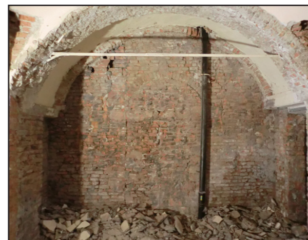
Figura 7.2.2.1.9.: Edificio 1, negozio 1, particolare dell'arco tamponato e della volta.
