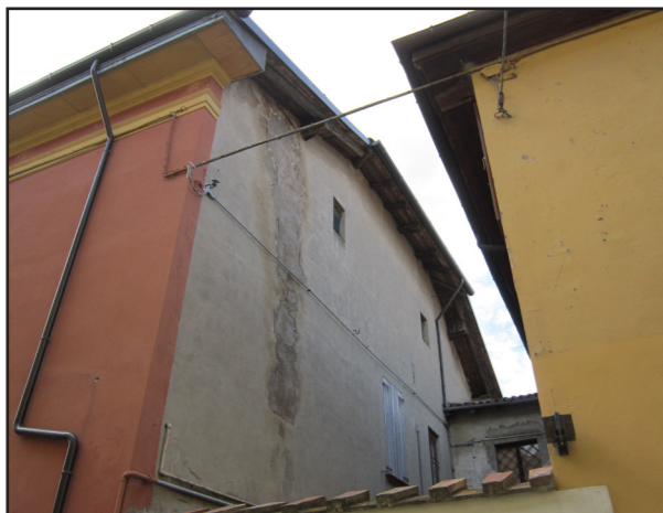
Figura 7.8.2.: Edificio VIII, copertura dall'esterno.
