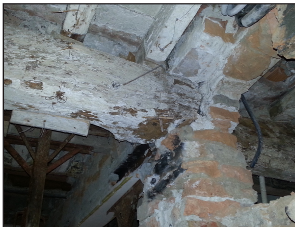
Figura 7.4.2.3.2.: Edificio III, piano secondo, maschio murario (fonte studio BBP ingegneria).
