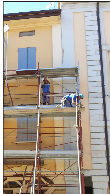
E. Particolare delle operazioni di messa in sicurezza della facciata a causa dell'attivazione del cinematiso fuori dal piano. In alto si vede, infatti, la disconnessione tra i due edifici già individuata dalla ricerca storica e verificata a causa degli eventi sismici.
