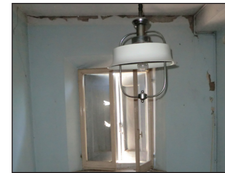
E. Altre lesioni dell'appartamento al secondo piano dell'edificio I. E' evidente il distacco della parete portante esterna non vincolata.
