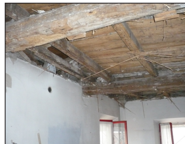
Figura 7.2.2.3.6.: Edificio I, appartamento 4, particolare della muratura.
