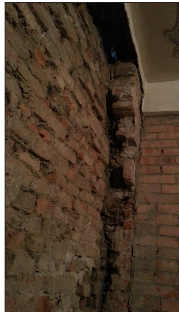
Figura 7.4.2.2.6.: Edificio III, piano primo, parete portante (fonte studio BBP ingegneria).
