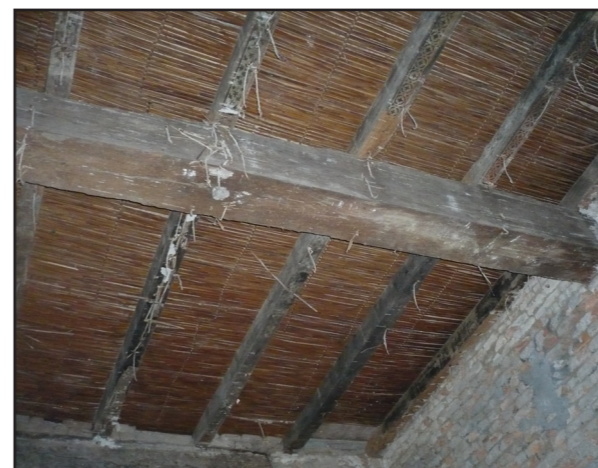
Figura 7.2.2.1.2.: Edificio 1, libreria, particolare delle decorazioni dei solai lignei.
