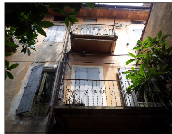
Figura 7.3.1.2.: Edificio II, prospetto sul cortile interno.
