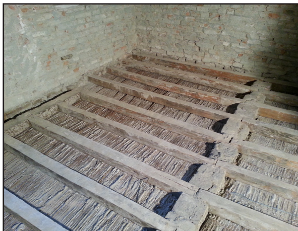
Figura 7.4.2.2.3.: Edificio III, piano primo, solaio ligneo (fonte studio BBP ingegneria).
