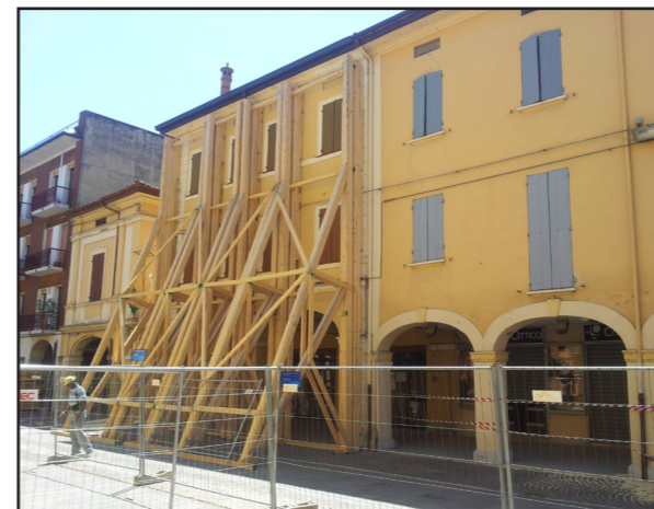
Figura 7.4.1.1.: Edificio III, prospetto principale su via Matteotti.
