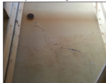
E. Lesione a taglio che attraversa tutto il maschio murario al piano terra su via Pigozzi.
