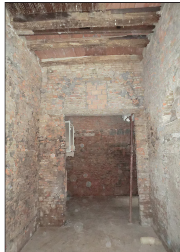
Figura 7.2.2.1.8.: Edificio 1, libreria, particolare dell'apertura ad arco tamponata.
