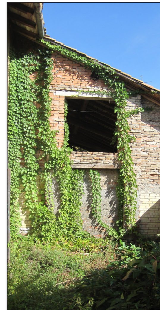
Figura 7.10.1.3.: Edificio X, prospetto sul cortile interno.
