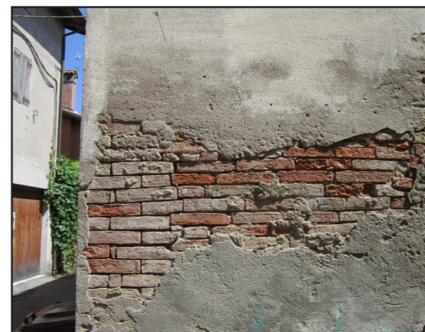
Figura 7.10.2.1.4.: Edificio X, piano terra, particolare dell'angolo sud-ovest.
