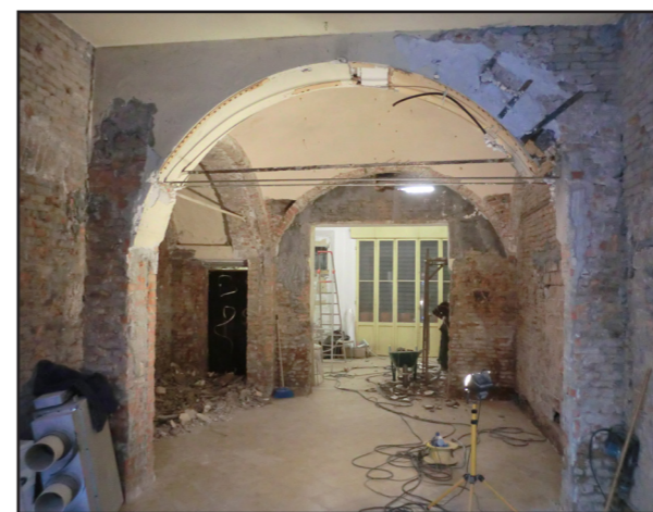
Figura 7.2.2.1.6.: Edificio I, negozio 1, particolare della volta.
