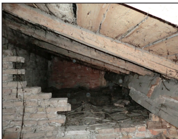
Figura 7.5.2.3.4.: Edificio IV, copertura, vista d'insieme del sottotetto.
