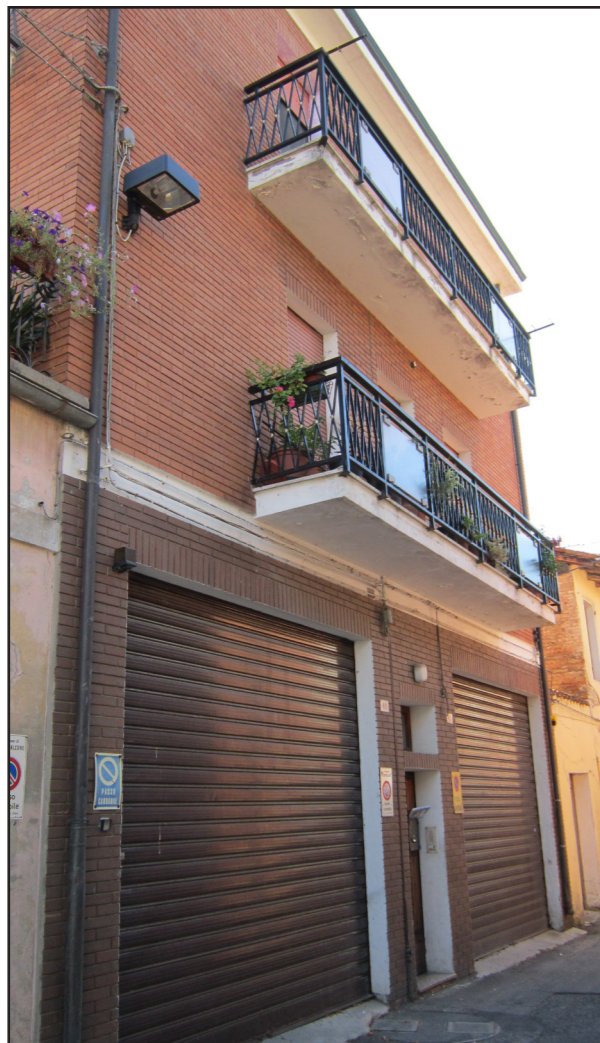
Figura 7.7.1.: Edificio VII, prospetto su via Bai.
