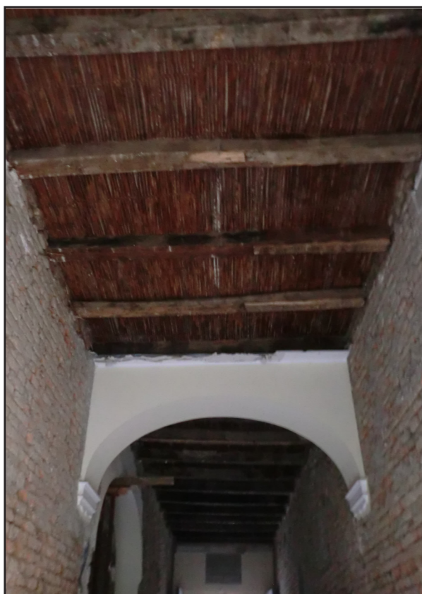
Figura 7.2.2.1.5.: Edificio I, androne e scale, particolare del solaio.
