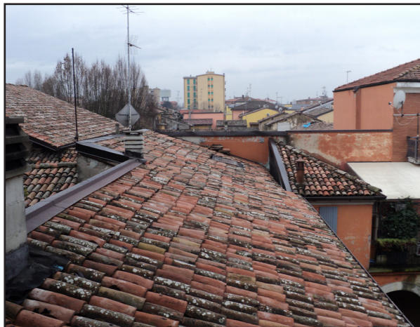
Figura 7.5.2.3.2.: Edificio IV, copertura vista dall'alto.
