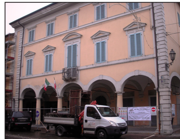
Figura 7.2.1.1.: Edificio I, prospetto sulla via Matteotti.
