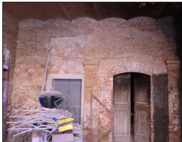
Figura 7.5.2.1.5.: Edificio IV, autorimesse e portico nell'ala sud, muratura.
