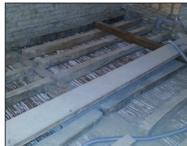
Figura 7.4.2.2.1.: Edificio III, piano primo, solaio ligneo (fonte studio BBP ingegneria).
