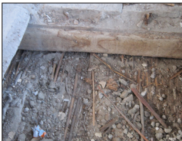
Figura 7.2.2.3.3.: Edificio I, appartamento 4, particolare del doppio arellato che costituisce la finta volta a padiglione del piano primo.
