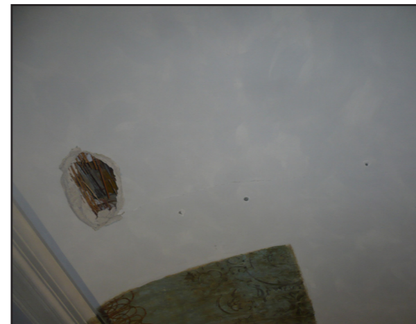
Figura 7.2.2.2.3.: Edificio I, appartamento 1, particolare della volta in arellato.
