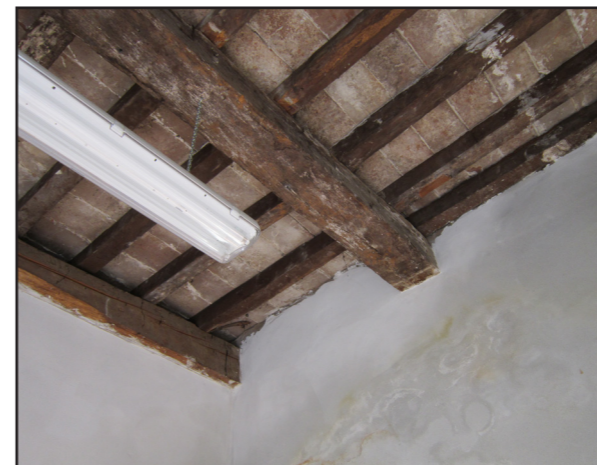
Figura 7.5.2.1.2.: Edificio IV, magazzino 2 nell'ala ovest, particolare del solaio ligneo.
