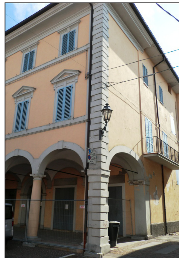
Figura 7.2.1.2.: Edificio I, prospetto sulla via T. Bai.
