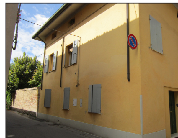
Figura 7.9.2.: Edificio IX, prospetto su via Sbaraglia Ponte.
