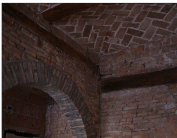
Figura 7.4.2.1.2.: Edificio III, piano terra, particolare delle travi (fonte studio BBP ingegneria).
