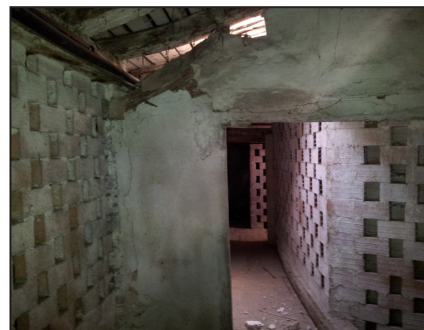
Figura 7.2.2.4.6.: Edificio I, sottotetto, particolare dei tamponamenti.
