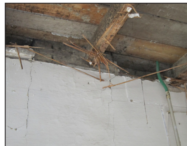
Figura 7.2.2.3.1.: Edificio I, appartamento 4, particolare dei solai.
