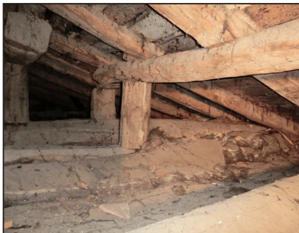
Figura 7.5.2.3.3.: Edificio IV, copertura, particolare di un rompitratta.
