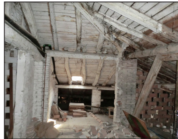
Figura 7.2.2.4.5.: Edificio I, sottotetto, particolare dei travetti e del colmo.
