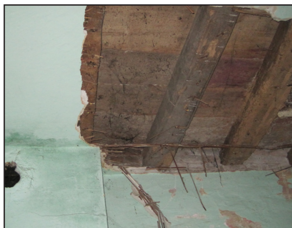
Figura 7.10.2.1.2.: Edificio X, piano terra, particolare del solaio.
