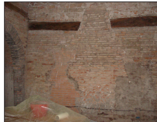
Figura 7.4.2.1.4.: Edificio III, piano terra, particolare murature (fonte studio BBP ingegneria).
