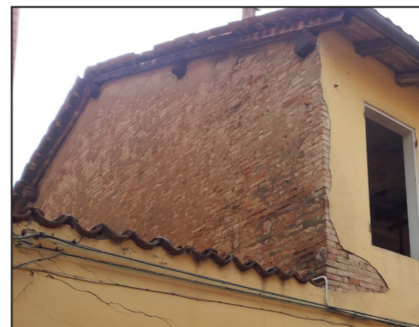
Figura 7.10.2.3.1.: Edificio X, copertura, particolare all'esterno.
