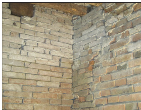
Figura 7.10.2.2.2.: Edificio X, piano primo, particolare degli ammorsamenti.
