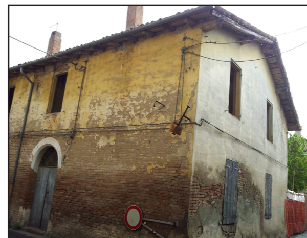
Figura 7.10.1.2.: Edificio X, prospetto su via Sbaraglia Ponente.
