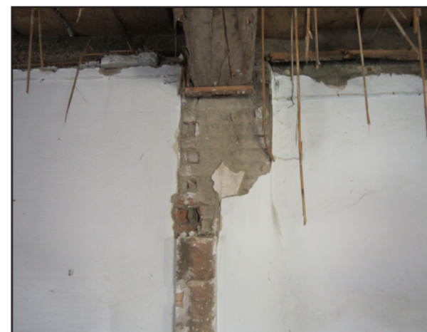
Figura 7.2.2.3.5.: Edificio I, appartamento 4, particolare della muratura.
