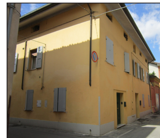
Figura 7.9.3.: Edificio IX, vista complessiva angolo sud-est.
