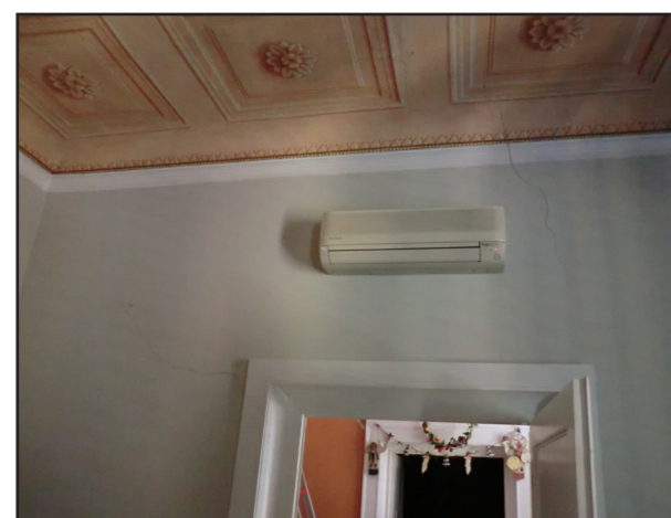
Figura 7.2.2.2.2.: Edificio I, appartamento 1, particolare del solaio finto cassettonato.
