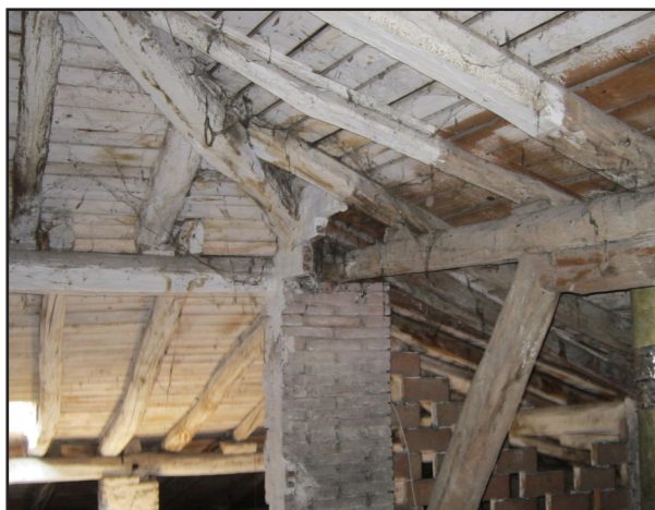
Figura 7.2.2.4.1.: Edificio I, sottotetto, particolare della copertura.
