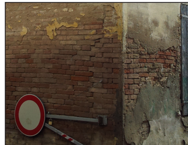
Figura 7.10.2.1.3.: Edificio X, piano terra, particolare dell'angolo sud-ovest.
