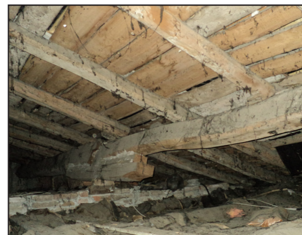
Figura 7.5.2.3.1.: Edificio IV, copertura, particolare delle travi.
