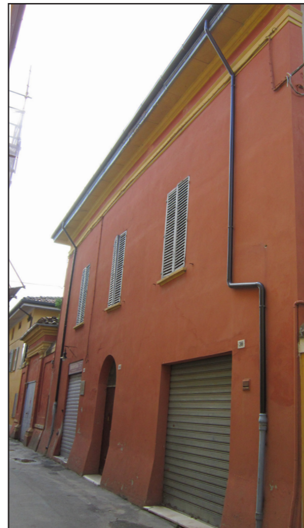
Figura 7.8.1.: Edificio VIII, prospetto su via Pigozzi.
