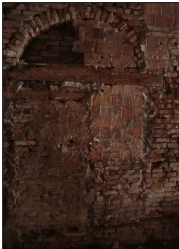
Figura 7.2.2.1.7.: Edificio 1, libreria, particolare dell'apertura ad arco tamponata in corrispondenza della volta.
