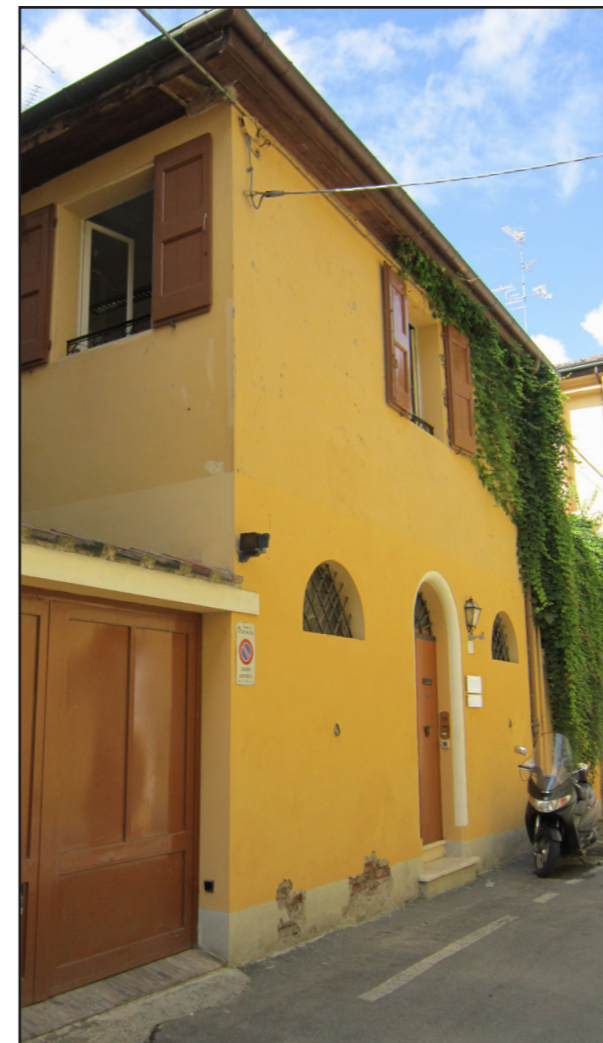
Figura 7.6.1.: Edificio VI, prospetto su via Pigozzi.
