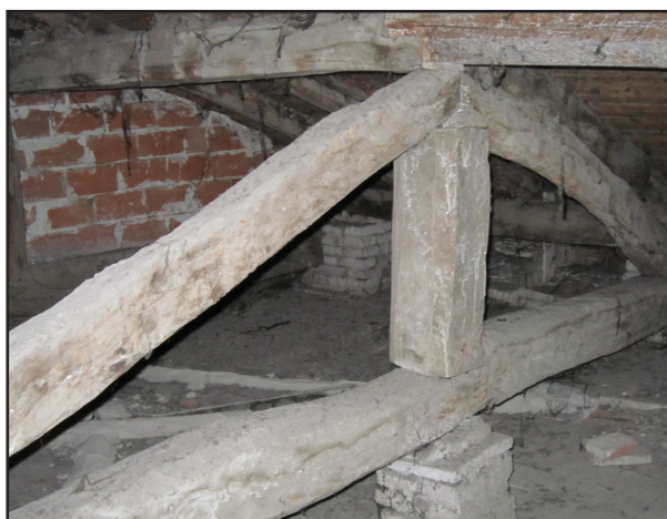
Figura 7.2.2.4.3.: Edificio I, sottotetto, particolare delle capriate.
