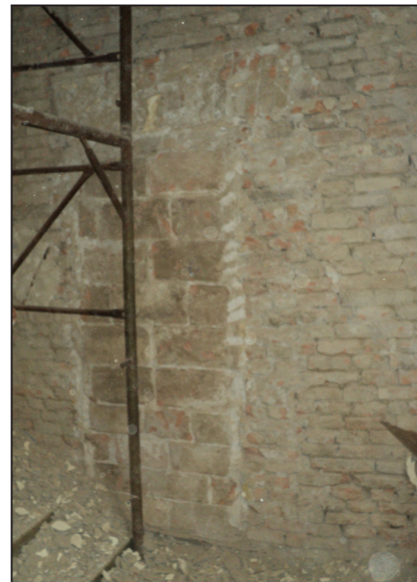
Figura 7.2.2.1.13.: Edificio I, scale, particolare dell'apertura tamponata.
