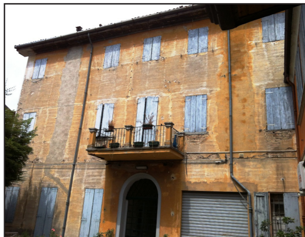
Figura 7.2.1.3.: Edificio 1, prospetto sul cortile interno.
