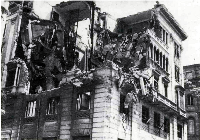
fig. I/51 - Dopo i bombardamenti: zona di piazza Roma, angolo corso Stamira, 1945
