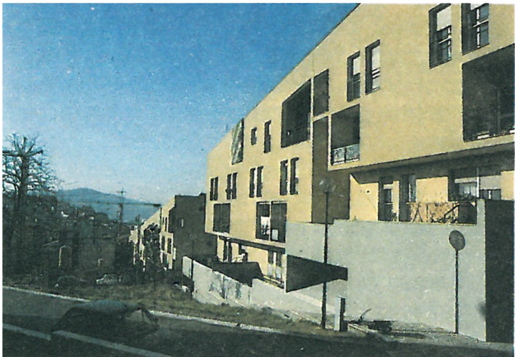
fig. I/94 - Complesso residenziale via Scosciacavalli, arch. Sergio Lenci 1975
