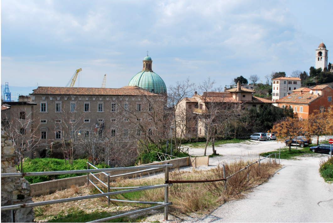
fig. III/4 - Area dell'ex convento di Santa Palazia, sguardo in direzione di palazzo Ferretti
