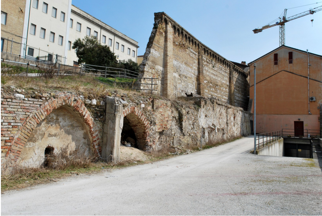
fig. III/6 - Porzione di muro dell'ex convento di Santa Palazia
