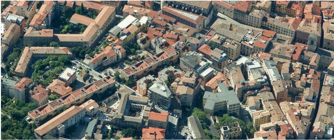
fig. I/91 - Complesso residenziale via Scosciacavalli, arch. Sergio Lenci 1975
