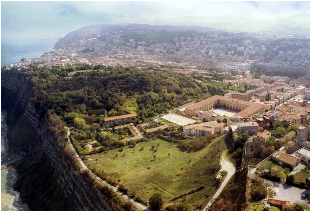
fig. II/3 - Fotografia aerea sul Parco del Cardeto (area Campo degli Ebrei, Caserma Villarey)
