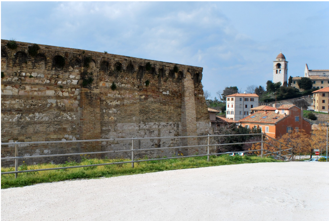
fig. III/5 - Porzione di muro dell'ex convento di Santa Palazia
