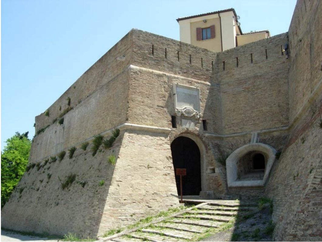
fig. I/17 - Ingresso della Fortezza - Cittadella di Ancona
