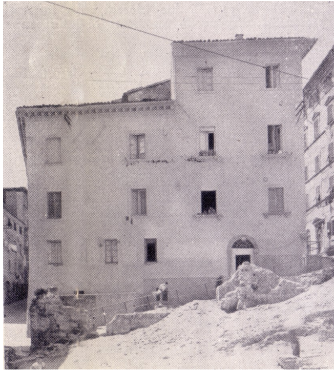
fig. I/77 - Rione Capodimonte 1956/57 fronte su vicolo Malacari Fotografia da M. Coppa, op. cit. - Bibl. Com. "Benincasa" di Ancona
