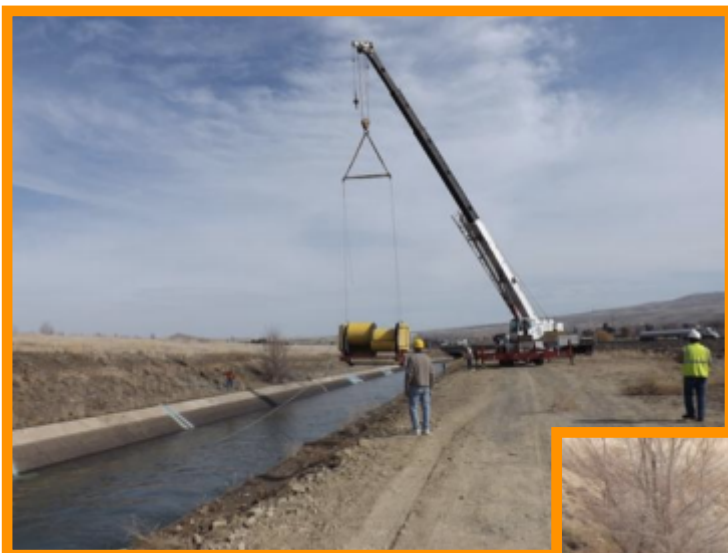
Figura 23 e BIS - Turbina Hydrovolts in fase di posa
