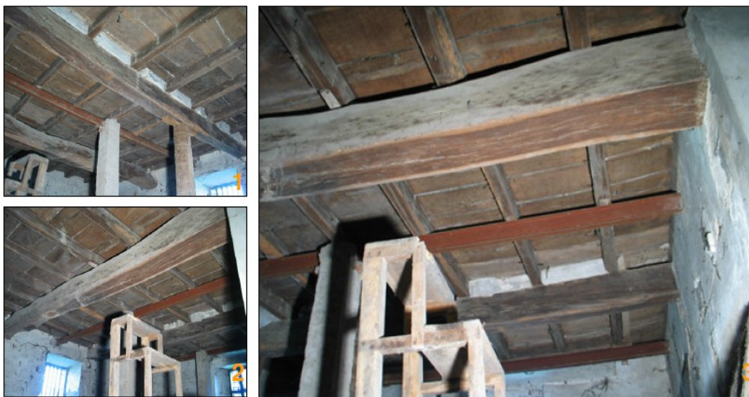
Figura 35: Travi lignee e putrella in acciaio del solaio del vano 112 [13]
