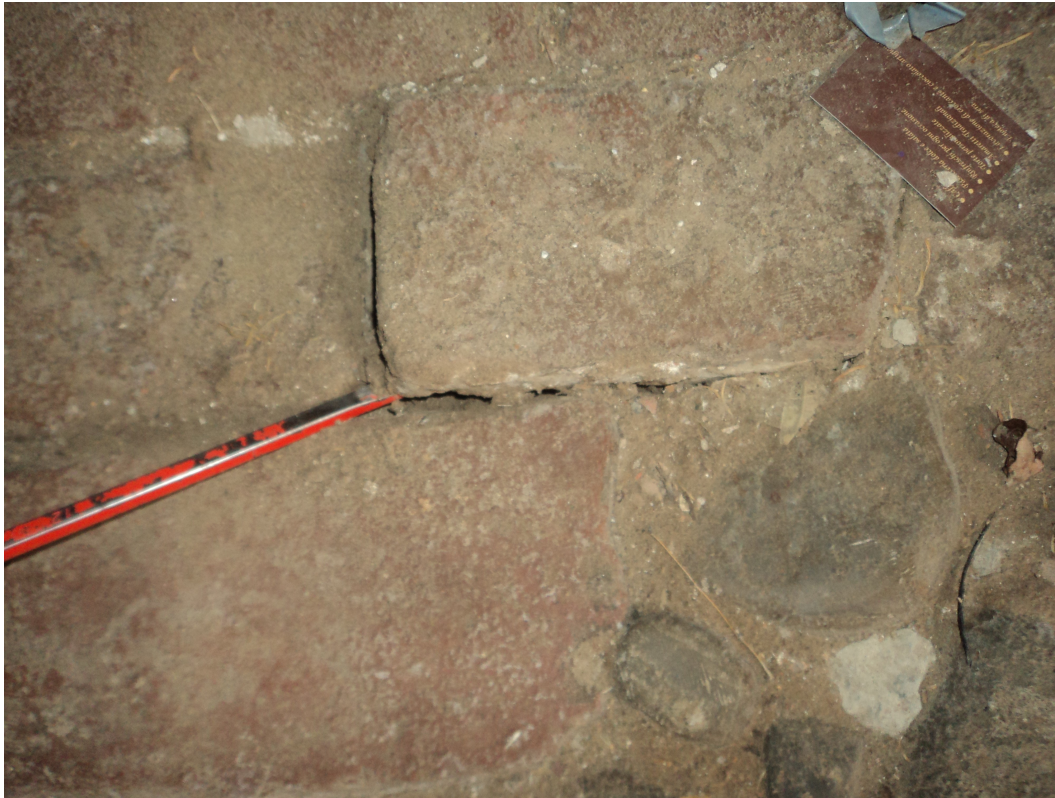
Figura 29 : Sollevamento del laterizio della pavimentazione
