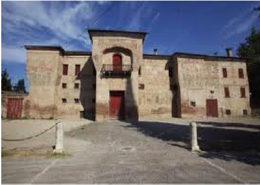
Figura 7 : Fronte ovest della Rocca prospiciente Piazzale Rangoni [9]
