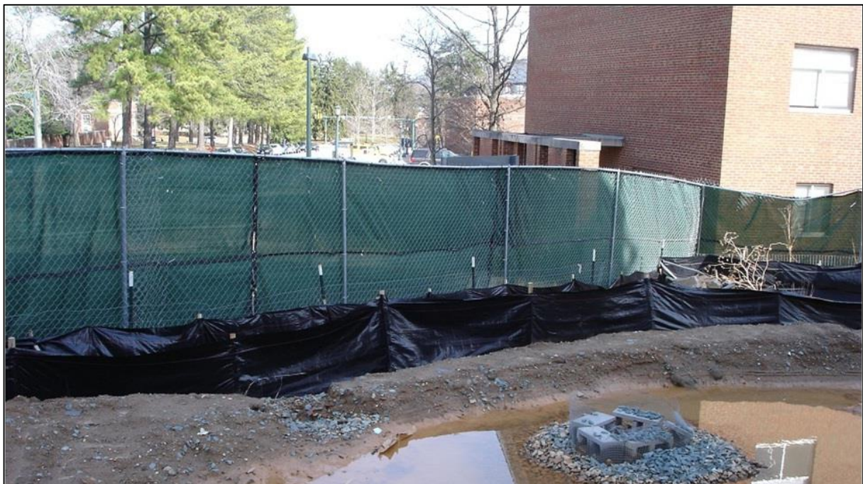
fig. 5: contenimento dei sedimenti nell'area di cantiere. Foto tratta da: http://ehs.virginia.edu/ehs/ehs.esc/examples.html
