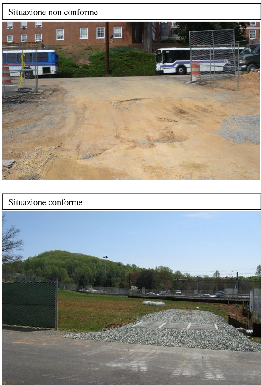
fig. 23: due differenti situazioni. In alto, immagine di ingresso senza pietrisco; in basso, ingresso con pietrisco. Foto tratte da : http://ehs.virginia.edu/ehs/ehs.esc/examples.html
