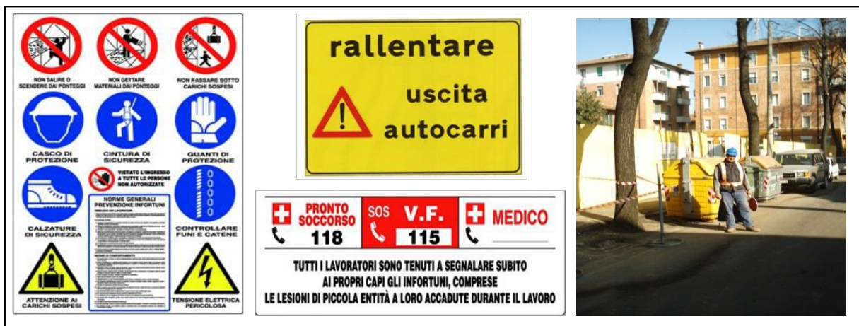
fig. 10:esempi di segnaletica e a destra esempio di moviere all'accesso del cantiere
