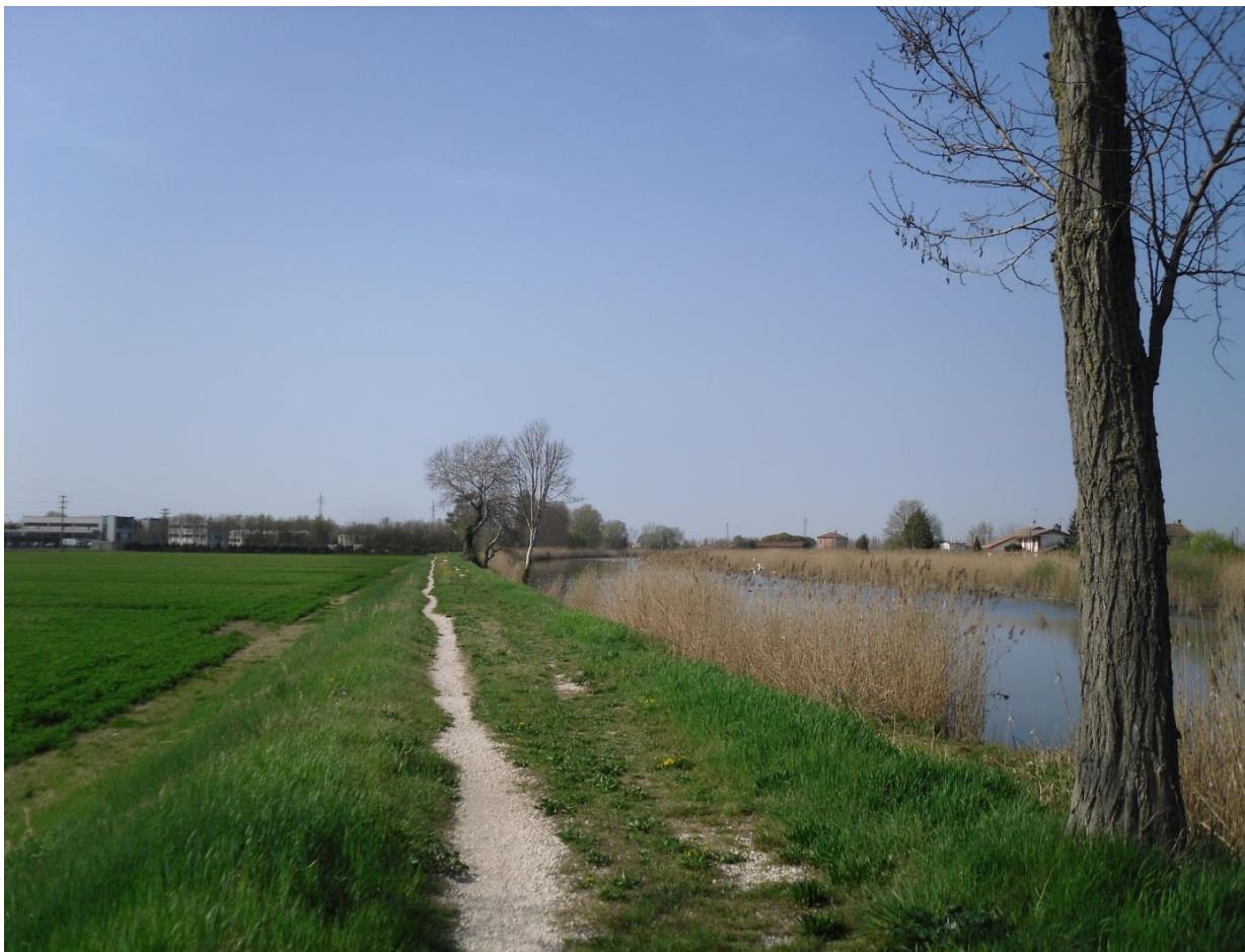
Argine fiume Sile
