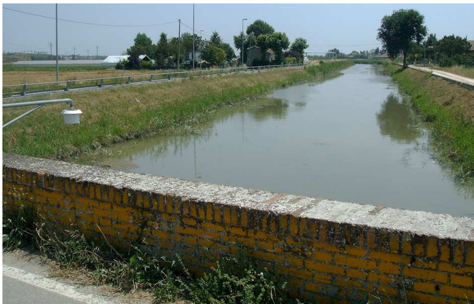
Fig.23 Vista del Canale di Allacciamento (verso valle) dal ponte di Via Visdomina.
