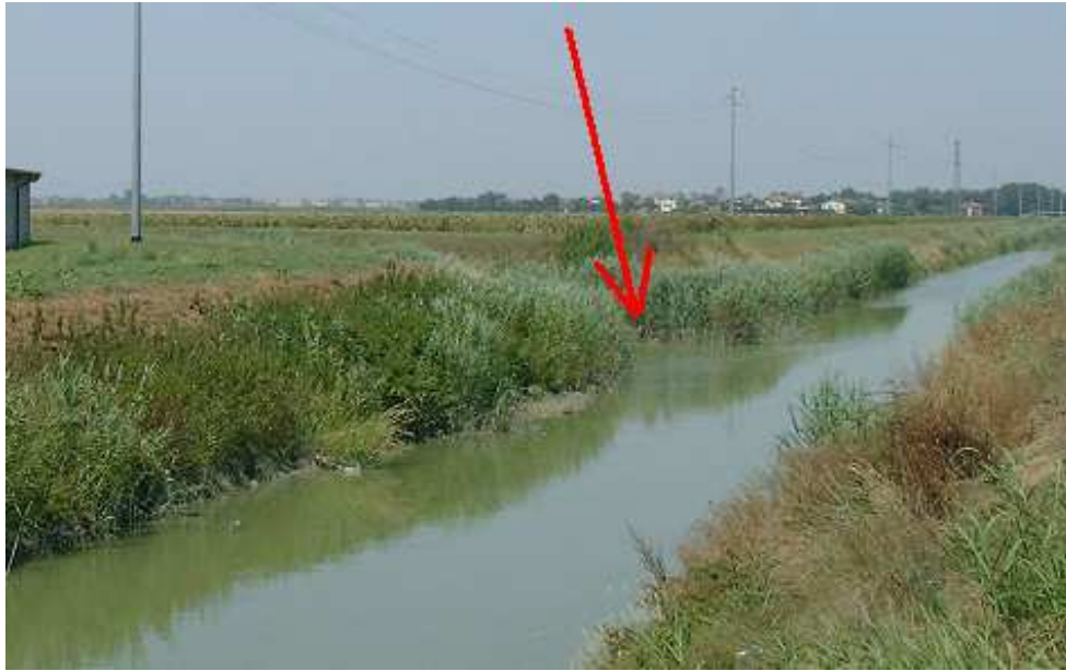
Fig.17 Il Canale di Allacciamento a monte del ponte sulla Strada Cervese. La freccia indica il punto in cui il Rio Granarolo (proveniente da sinistra e nascosto dalla vegetazione) si immette nel canale.
