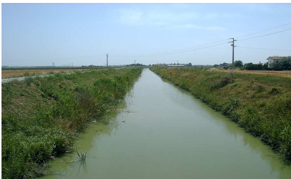
Fig.16 Il Canale di Allacciamento a valle del ponte sulla Strada Cervese.
