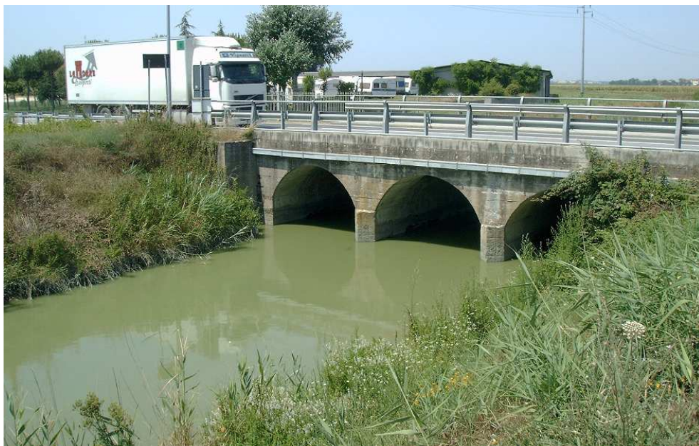
Fig.26 Vista del Canale di Allacciamento a valle dal ponte sulla Strada Cervese.
