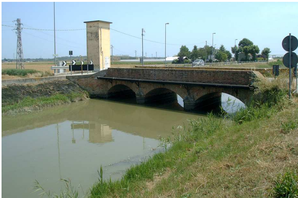
Fig.18 Il Canale di Allacciamento a monte del ponte di Via Visdomina.
