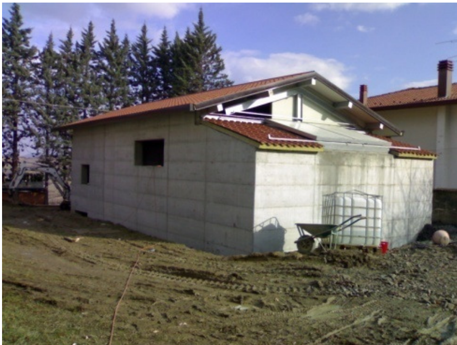
Fase di costruzione del locale caldaia con silos per il cippato
