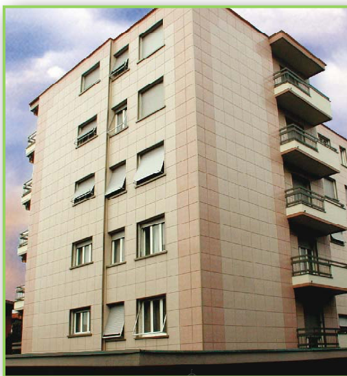
Fig. 2.4 : Edificio dopo l'applicazione della parete ventilata
