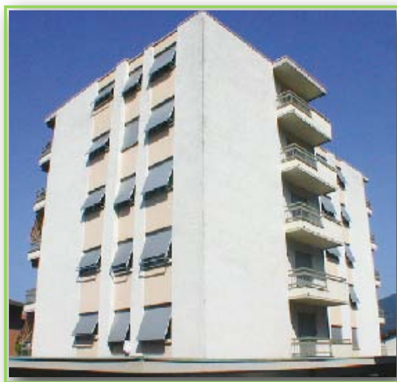
Fig. 2.3 : Edificio prima della ristrutturazione con pareti ventilate
