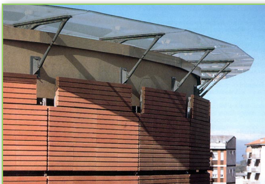
Fig. 2.40 : Facciata ventilata della Banca Popolare di Lodi di R. Piano (Lodi, 1999): particolare in prossimità dell'apertura di uscita dell'aria dall'intercapedine e soluzione di copertura
