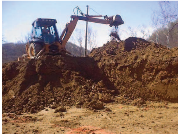
Fig.7 – Terre e rocce da scavo.
