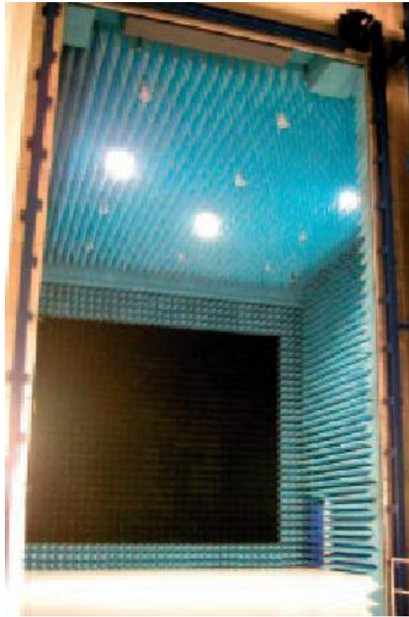
Figura 34 Particolare della camera anecoica Maxwell
