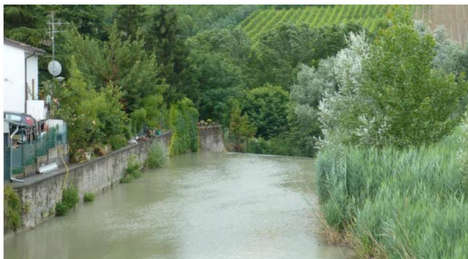
Figura 2- vista della briglia da monte , muro d'ala in sinistra idraulica
