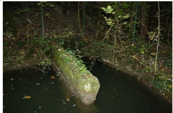
Figura 3.10 - Il muro di desabbiatura
