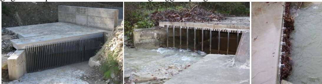
Figura 3.17 - La griglia in ingresso, appena montata, sezionata ed intasamento
