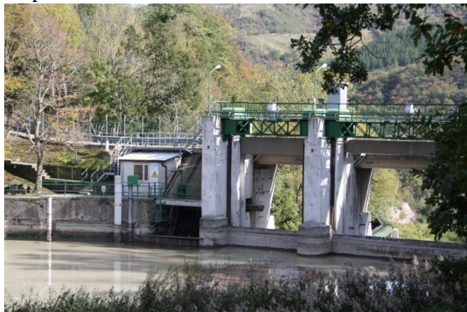
Figura 3.1 - vista da monte
