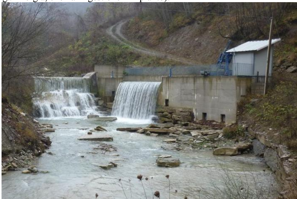
Figura 3.16 - L'opera di presa del Para 1
