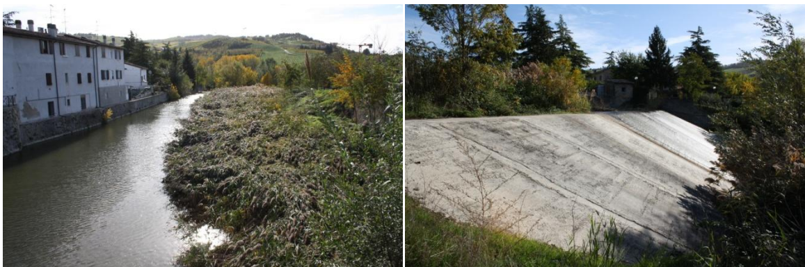
Figura 4.1 - La briglia vista da monte e lateralmente, sulla sponda destra del fiume Rabbi
