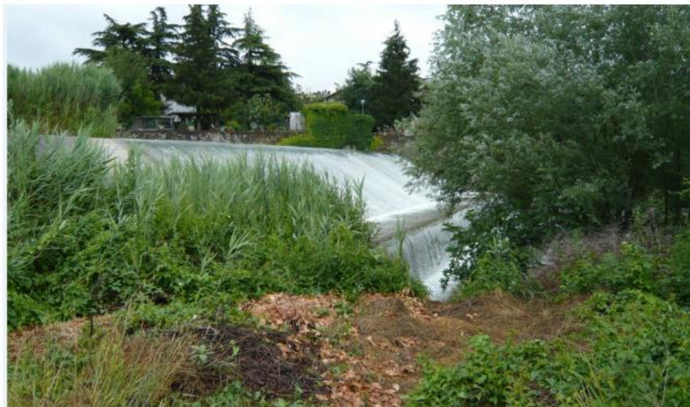
Figura 3- vista della briglia lato valle
