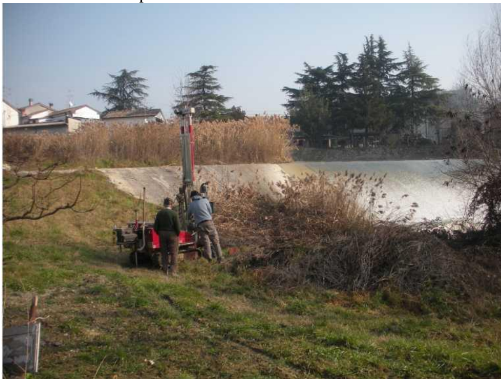
Situazione della vegetazione sulla sponda destra del fiume
