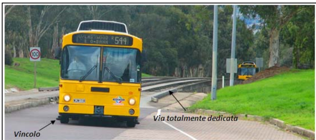
Figura 4.5 – O-Bahn all'ingresso di una stazione
