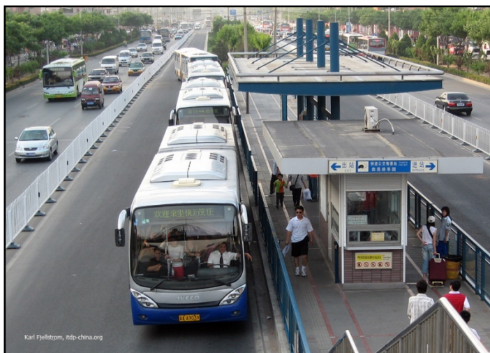
Figura 4.13 – Stazione BRT Beijing
