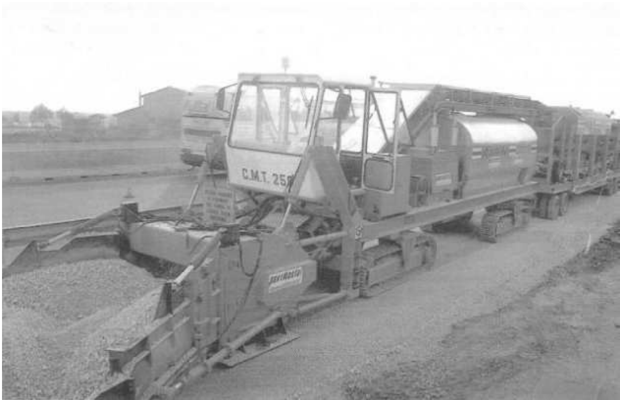
Figura 3. 21: Foto di un treno di riciclaggio CMT 250 della MARINI (Pavimental Autostrade spa)
