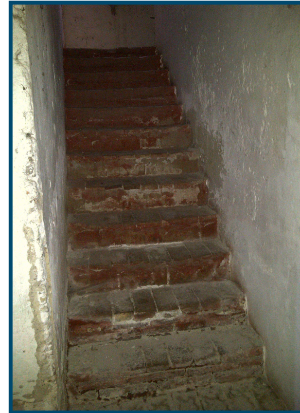
Scala da piano terra a primo piano
