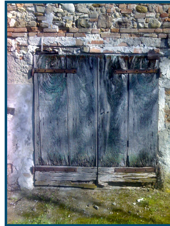
Porta della cantina vista dall'esterno
