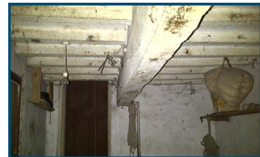
Tipico esempio di soffitto ligneo della porzione abitativa
