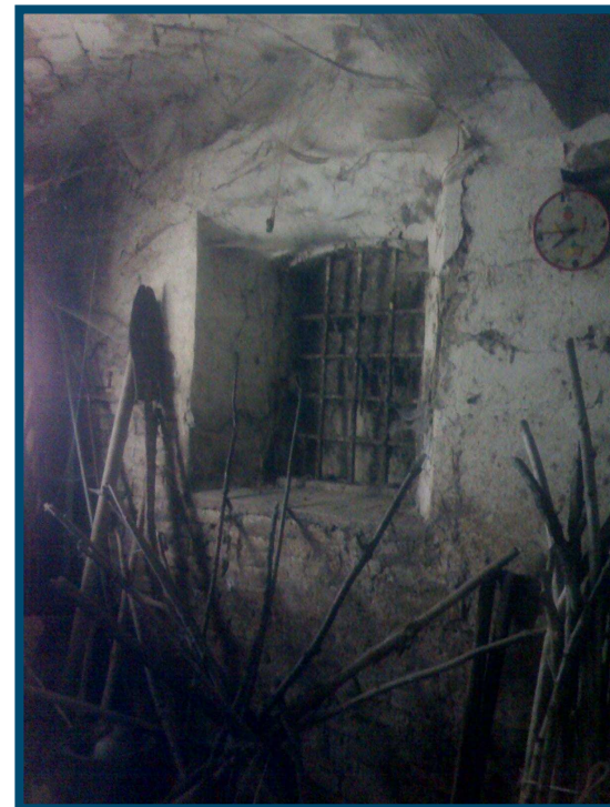
Finestra stalla a piano terra
