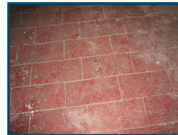
Pavimentazione della parte abitativa
