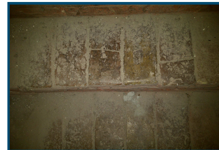
Particolare pavimentazione della scala con mattoni tinti di rosso
