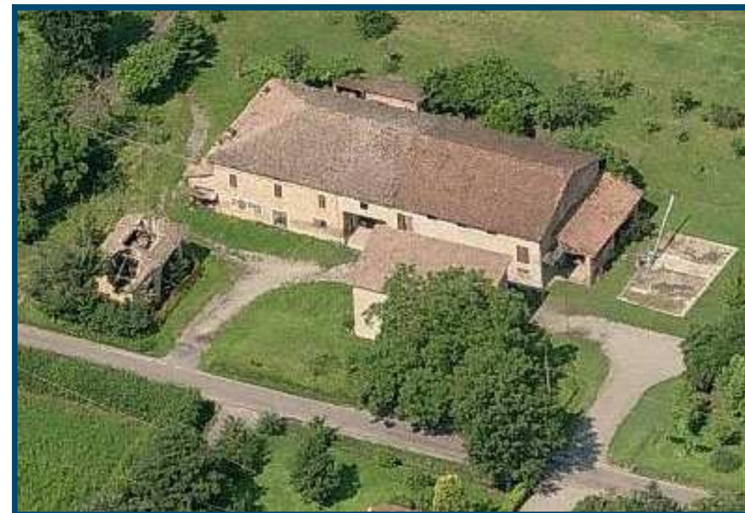
Edificio in esame
