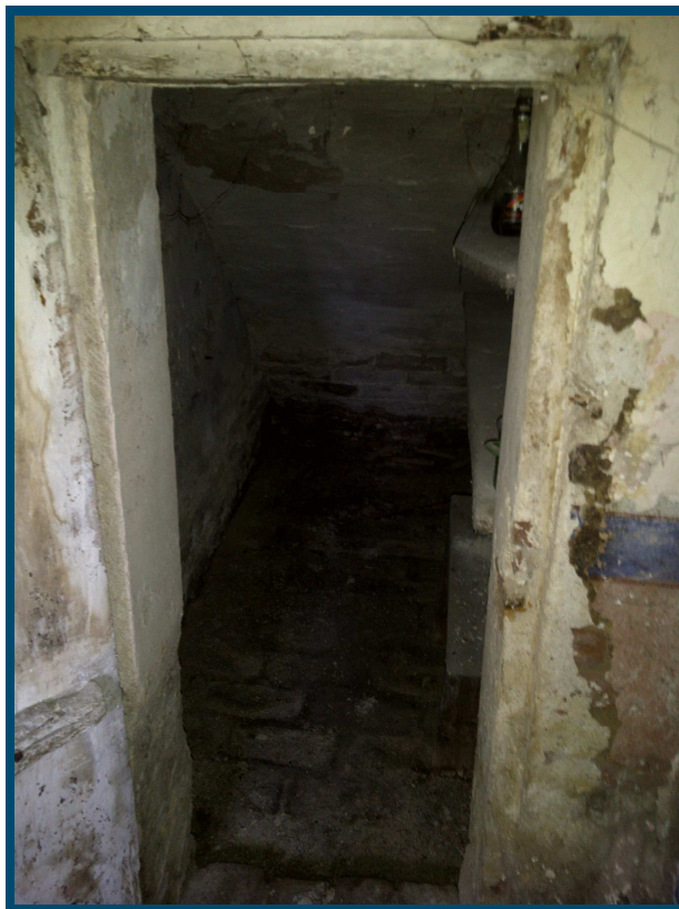
Accesso al sottoscala
