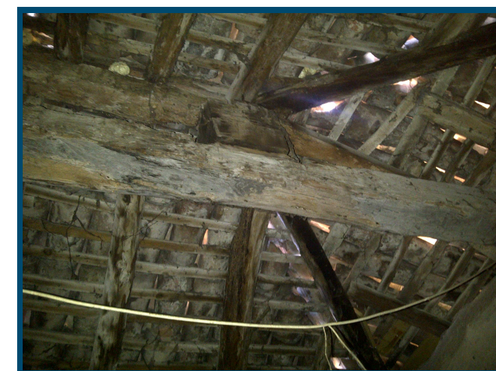
Particolare trattamento del colmo
