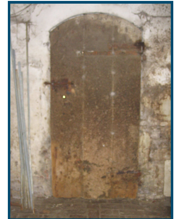
Porta della stalla verso l'esterno
