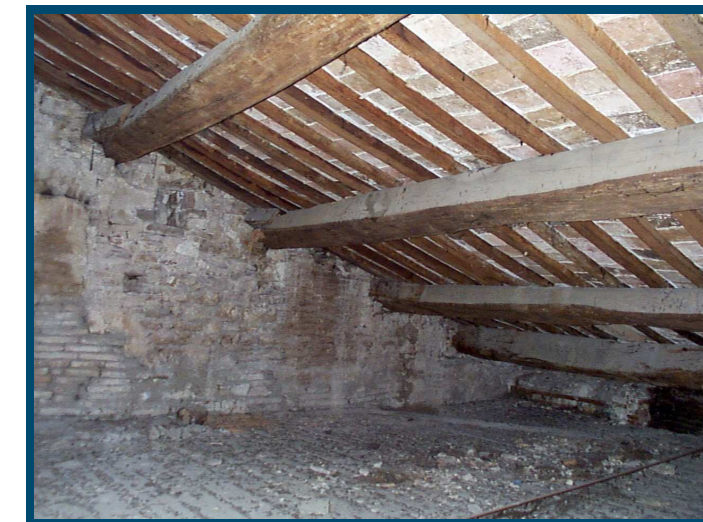
Tipica copertura lamberciata al di sopra della “porta morta”
