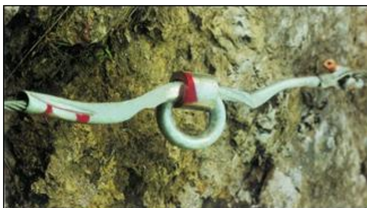
Figura 1.2: Particolare di un ancoraggio alla parete rocciosa
