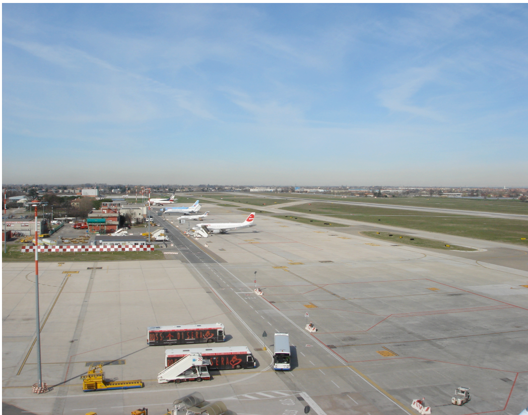
Figura 5.7: Piazzale 2 visto dalla torre di controllo
