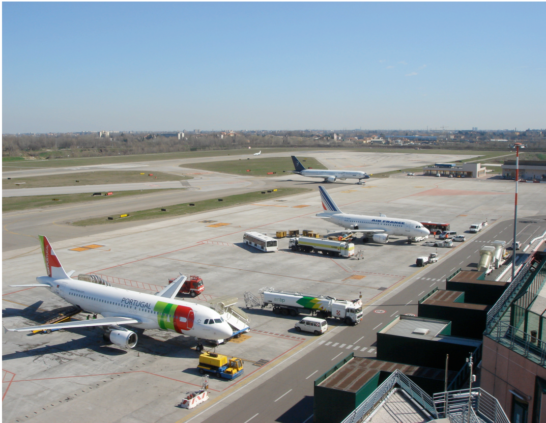
Figura 5.6: Piazzale 1 visto dalla torre di controllo
