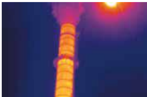
Figura 6.2.2.o - Ispezione del materiale refrattario nel camino di una camera di combustione
