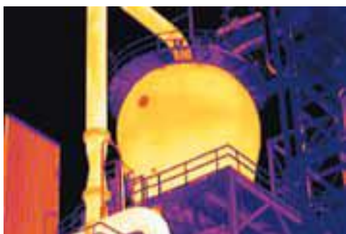
Figura 6.2.2.l - Ispezione dell'isolamento refrattario in un reattore petrolchimico
