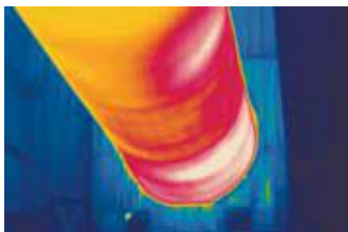
Figura 6.2.2.n - Decadimento di materiale refrattario in un forno rotativo per cemento
