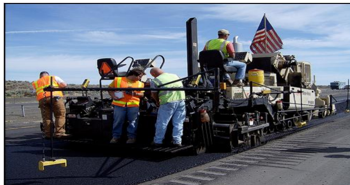
Figura 3.13 – Riduzione della produzione di fumi durante la stesa di un Warm Mix Asphalt
