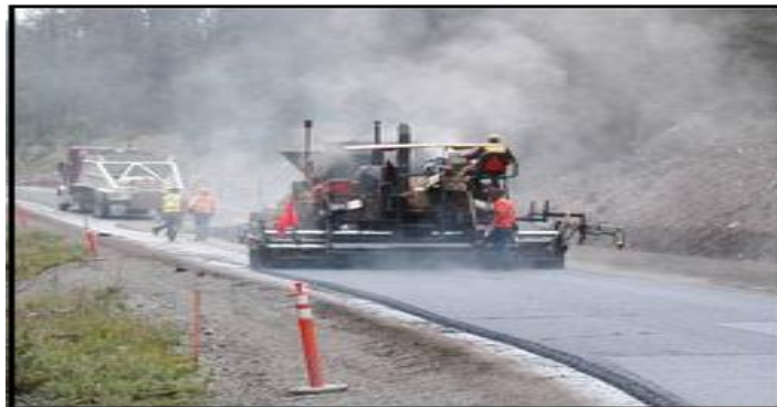
Figura 3.12 – Fumi prodotti alla stesa di un Hot Mix Asphalt
