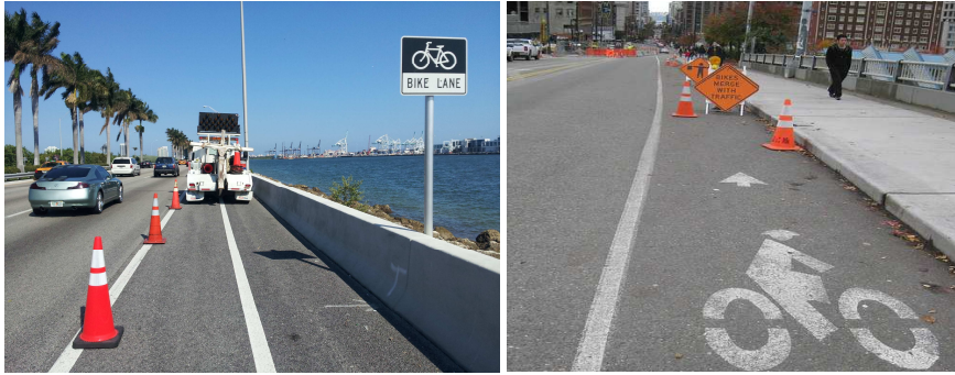
Figura 62 Disagi provocati da lavori in corso
