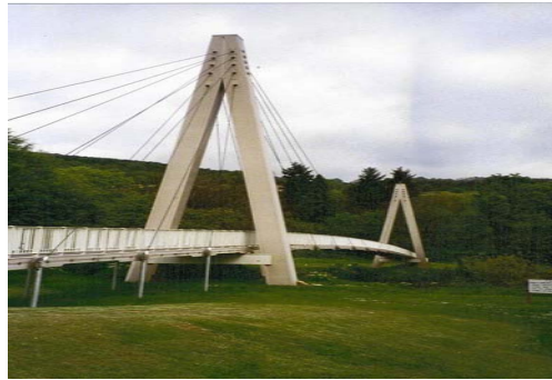
Figura 1 Ponte pedonale di Aberfeldy
