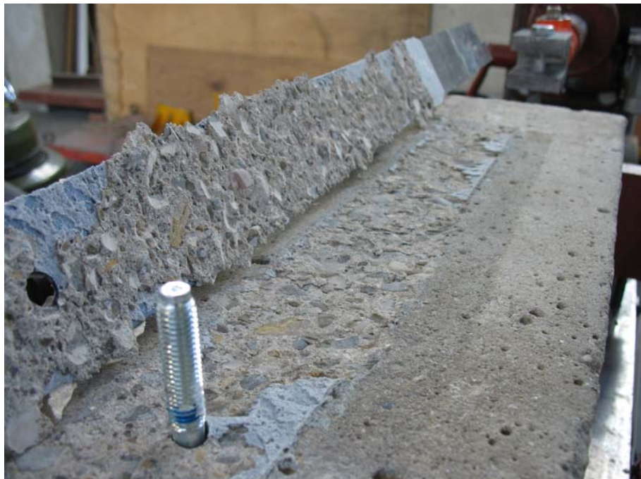
Figura 3.27.7 Particolare superficie delaminata
