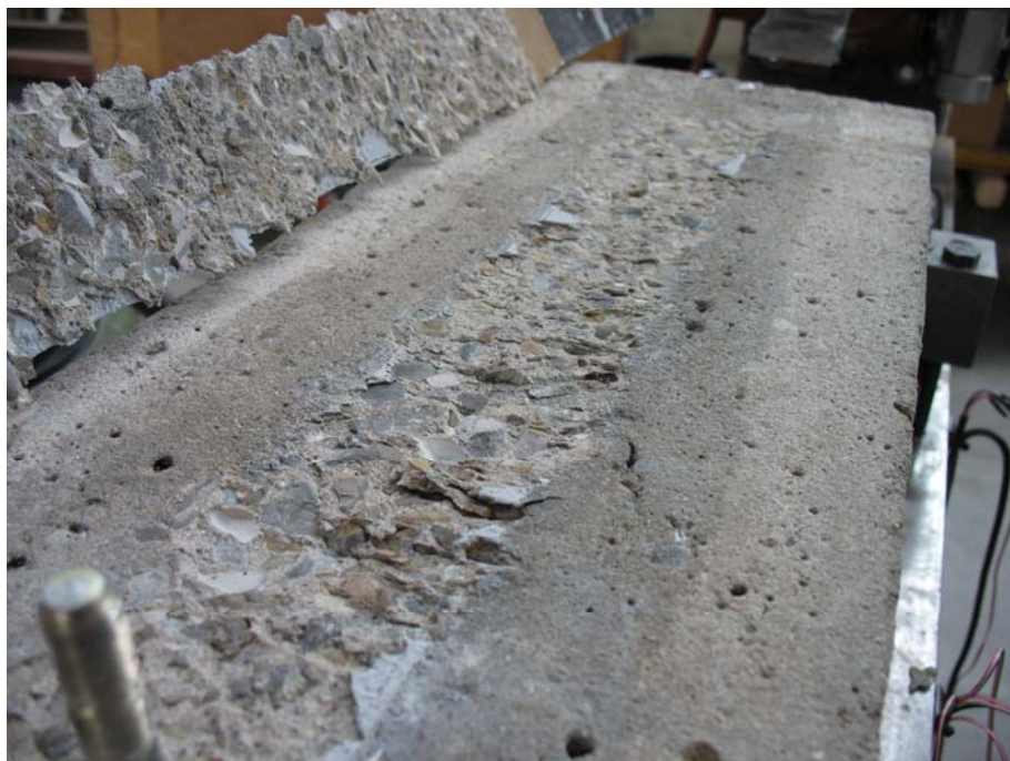
Figura 3.14.4 Particolare superficie delaminata
