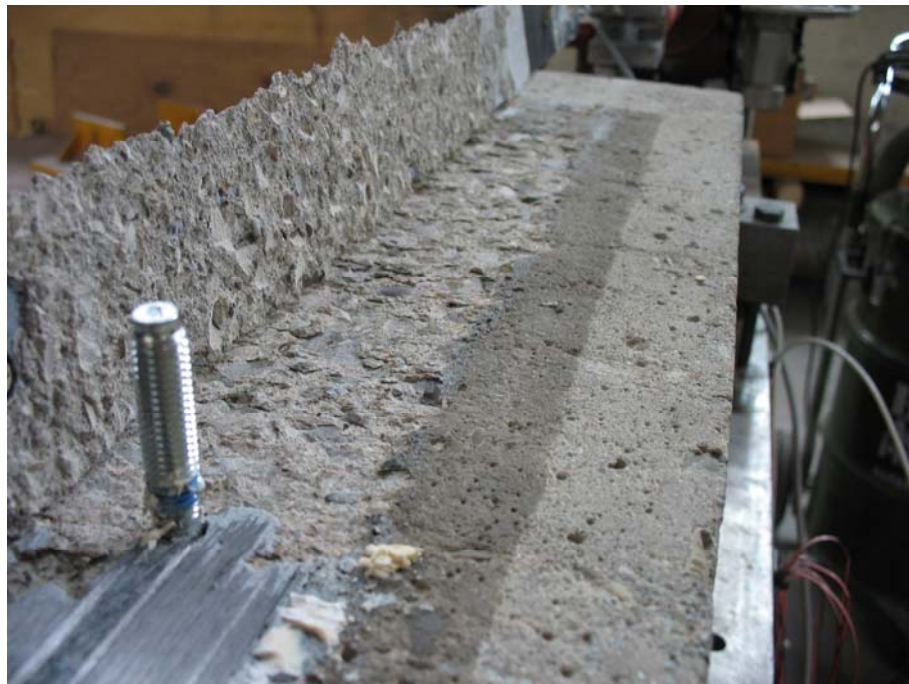
Figura 3.25.4 Particolare superficie delaminata
