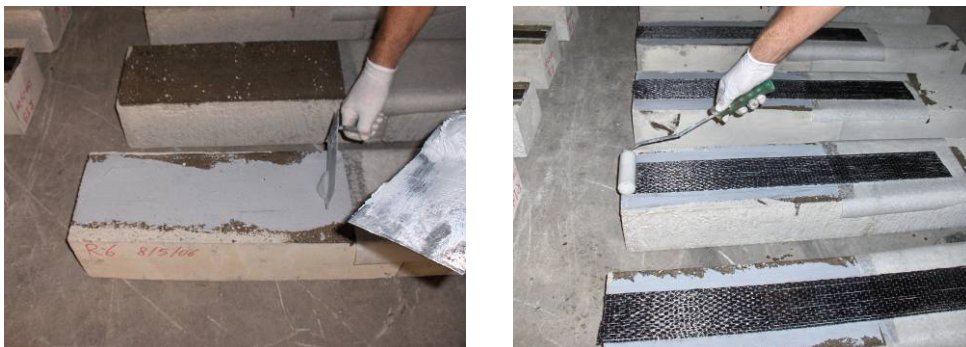
Figura 2.3 Rinforzo dei prismi con tessuto.
