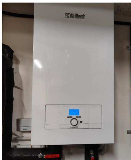
Figura 34. Caldaia elettrica Vaillant
