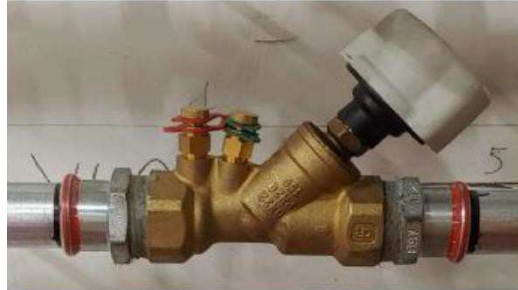
Figura 44. Valvola di bilanciamento Caleffi
