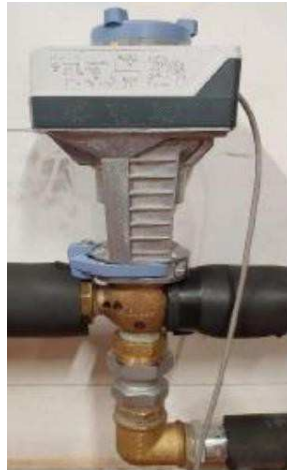
Figura 43. Valvola a tre vie modulante Siemens
