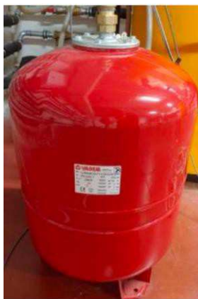
Figura 47. Vaso di espansione Varem
