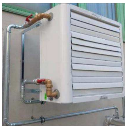
Figura 38. Aerotermo Galletti
