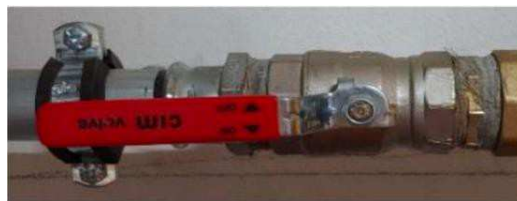
Figura 41. Valvole di intercettazione a sfera Cimberio
