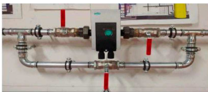
Figura 31. Pompa di circolazione con ramo di by-pass
