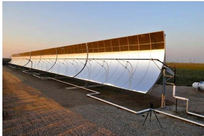
Figura 12. Pannelli solari a depressione parabolica [10]
