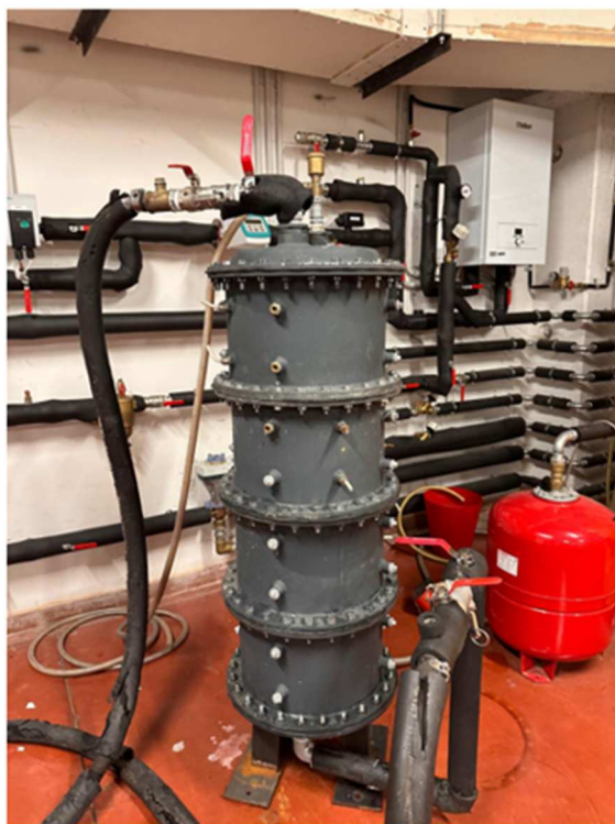
Figura 63. Immagine reale dell'accumulo termico (a) e schematizzazione dell'accumulo con la posizione dei 7 sensori di temperatura (b)
