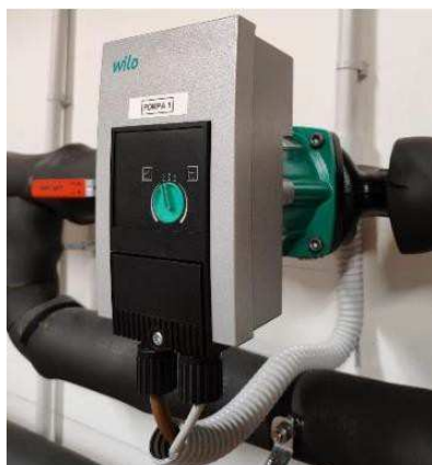
Figura 35. Pompa di circolazione Wilo
