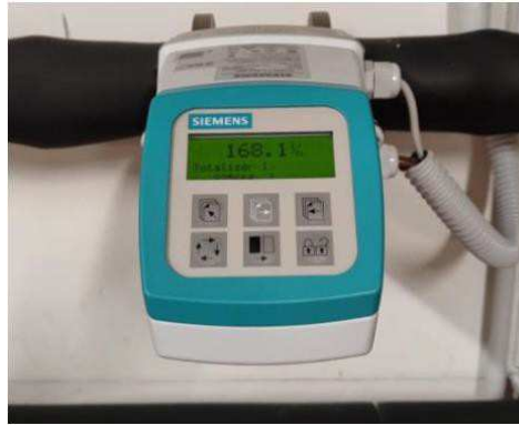
Figura 40. Misuratore di portata Siemens
