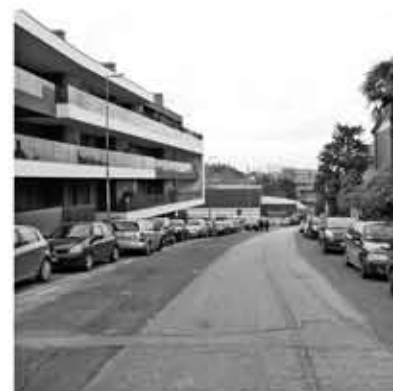
Vista da via Magellano
