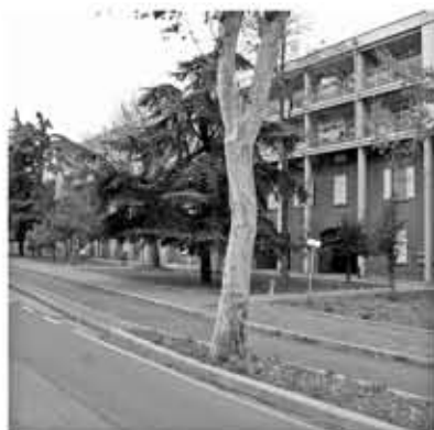
Vista da viale Oberdan
