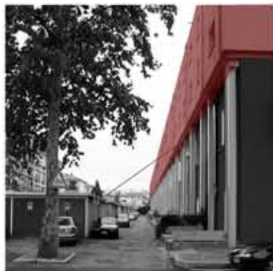
Studio visivo della strada interna di servizio
