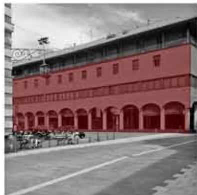
Studio visivo da corso Mazzini sulla piazza
