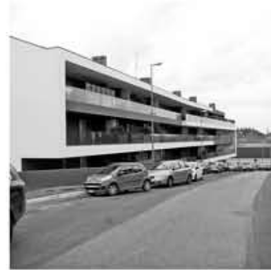
Vista da via Magellano
