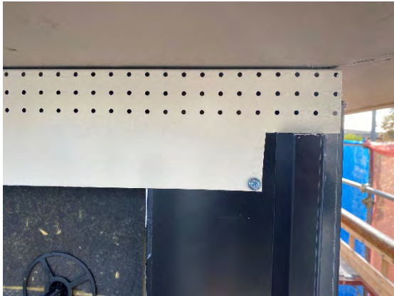
Fig.113 Documentazione di cantiere. Particolare della griglia di areazione del bordo superiore della facciata ventilata.
