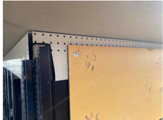
Fig.113 Documentazione di cantiere. Particolare della griglia di areazione del bordo superiore della facciata ventilata.
