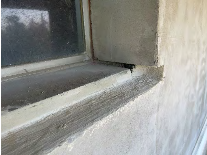
Fig.48 CA_11: Documentazione fotografica di cantiere. Rasatura finale, sopra l'isolante e predisposizione per la posa dei nuovi bancali in sovrapposizione agli esistenti.
