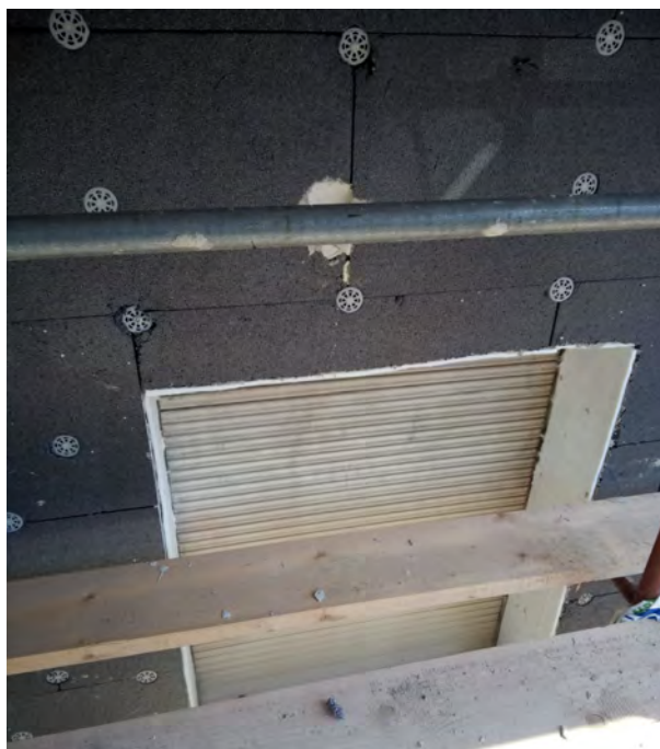
Fig.47 Documentazione fotografica di cantiere. A sinistra, MCA_2: Isolamento degli imbotti delle aperture con pannelli in aerogel. A destra, CA_3: unico caso di isolamento delle spallette verticali mediante pannelli in polistirolo ad alta densità (vedi CA_3: spessore 1,5 cm, conducibilità termica 0,032 W/mK), con applicazione analoga a quella dei pannelli in aerogel.
