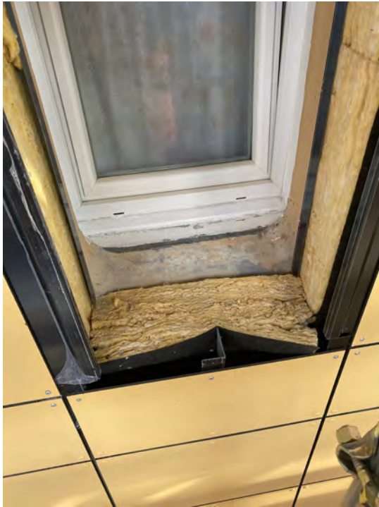
Fig.49 Da sinistra, particolare della parete ventilata, isolata con pannelli semirigidi in lana minerale, in corrispondenza degli infissi con aperture irregolari: la cornice in calcestruzzo non risulta raccordata né con lo strato isolante della parete né con la cornice metallica di finitura. Il ponte termico risulta pertanto non eliminato.
