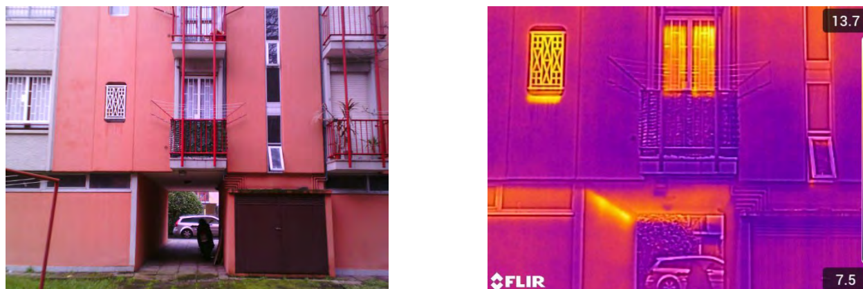
Fig.109 SC_via Puccini 17-19. Condizioni di rilevazione passive, fascia oraria 10-11 (cielo coperto e alta umidità). Prospetto est.
