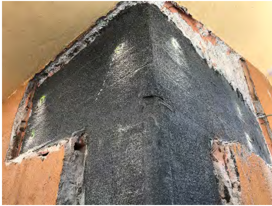
Fig.53 Documentazione fotografica di cantiere. CA_14: fasce di piano FRP e connettori.
