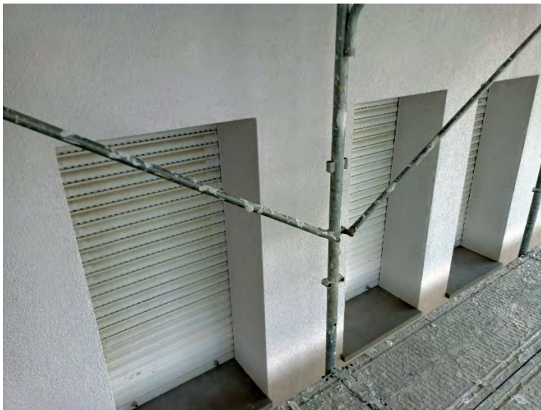
Fig.15 Documentazione fotografica di cantiere. Strato di intonaco di finitura.
