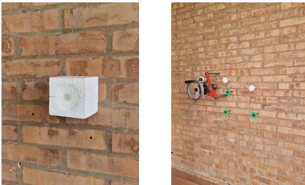
Fig.10 Documentazione fotografica di cantiere. CA_15: prova di tenuta allo strappo eseguita in cantiere con dinamometro a strappo.
