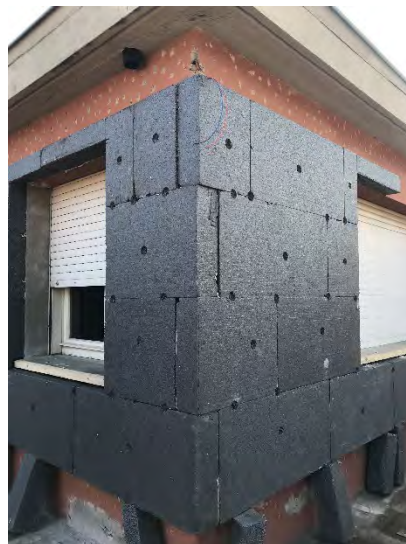
Fig.9 A sinistra, schema di montaggio dei pannelli ammorsati agli spigoli [11]. A destra, MCA_2: Documentazione di cantiere; particolare di ammorsamento dei pannelli isolanti, in EPS con grafite, agli spigoli dell'edificio. Predisposizione dei fori sui pannelli per tassellamento con schema a T.
