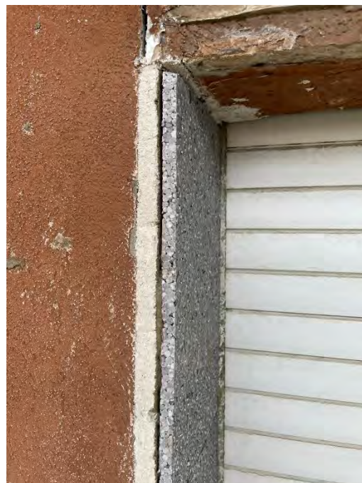
Fig.47 Documentazione fotografica di cantiere. A sinistra, MCA_2: Isolamento degli imbotti delle aperture con pannelli in aerogel. A destra, CA_3: unico caso di isolamento delle spallette verticali mediante pannelli in polistirolo ad alta densità (vedi CA_3: spessore 1,5 cm, conducibilità termica 0,032 W/mK), con applicazione analoga a quella dei pannelli in aerogel.
