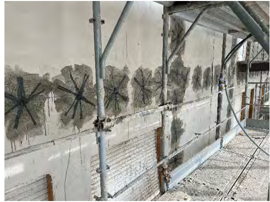
Fig.53 Documentazione fotografica di cantiere. CA_14: fasce di piano FRP e connettori.
