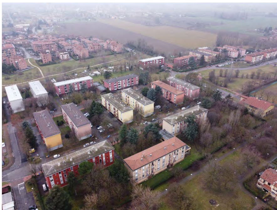
Fig.39 Documentazione fotografica di cantiere. SC: vista aerea da drone.
