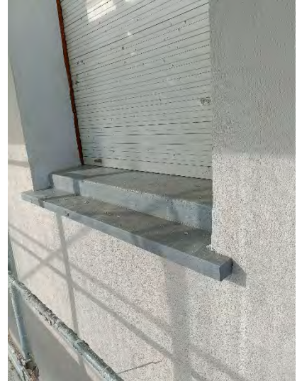
Fig.48 CA_11: Documentazione fotografica di cantiere. Rasatura finale, sopra l'isolante e predisposizione per la posa dei nuovi bancali in sovrapposizione agli esistenti.
