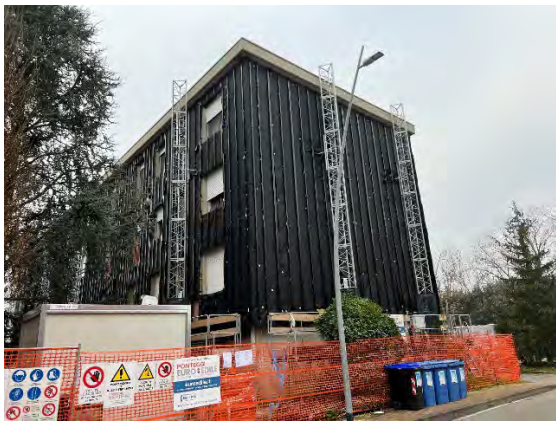
Fig.112 SC_8: condizioni di rilevazione passiva, 11-12 (cielo coperto). Prospetto est. In basso a sinistra, particolare di cantiere degli ancoraggi, nascosti tra i pannelli in lana minerale, di supporto alla sottostruttura della parete ventilata.
