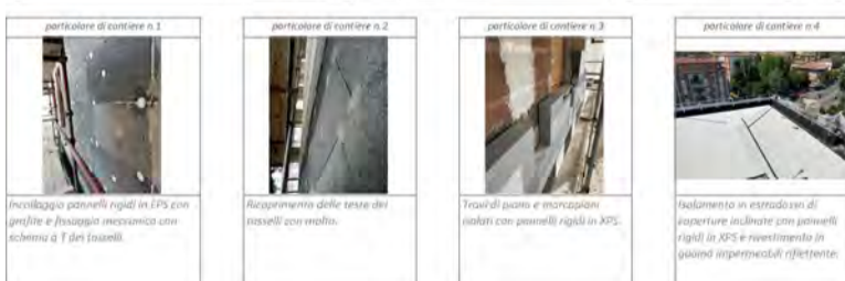
Particolare di cantiere n. 1: Isolamento pannelli rigidi in EPS con grafite e fissaggio meccanico con schema a T dei tasselli. Particolare di cantiere n. 2: Ripascimento delle teste dei tasselli con malta. Particolare di cantiere n. 3: Tasselli piano e marcapiani isolati con pannelli rigidi in XPS. Particolare di cantiere n. 4: Isolamento in estradosso di aperture inclinate con pannelli rigidi in XPS e rivestimento in guaina impermeabile riflettente.
