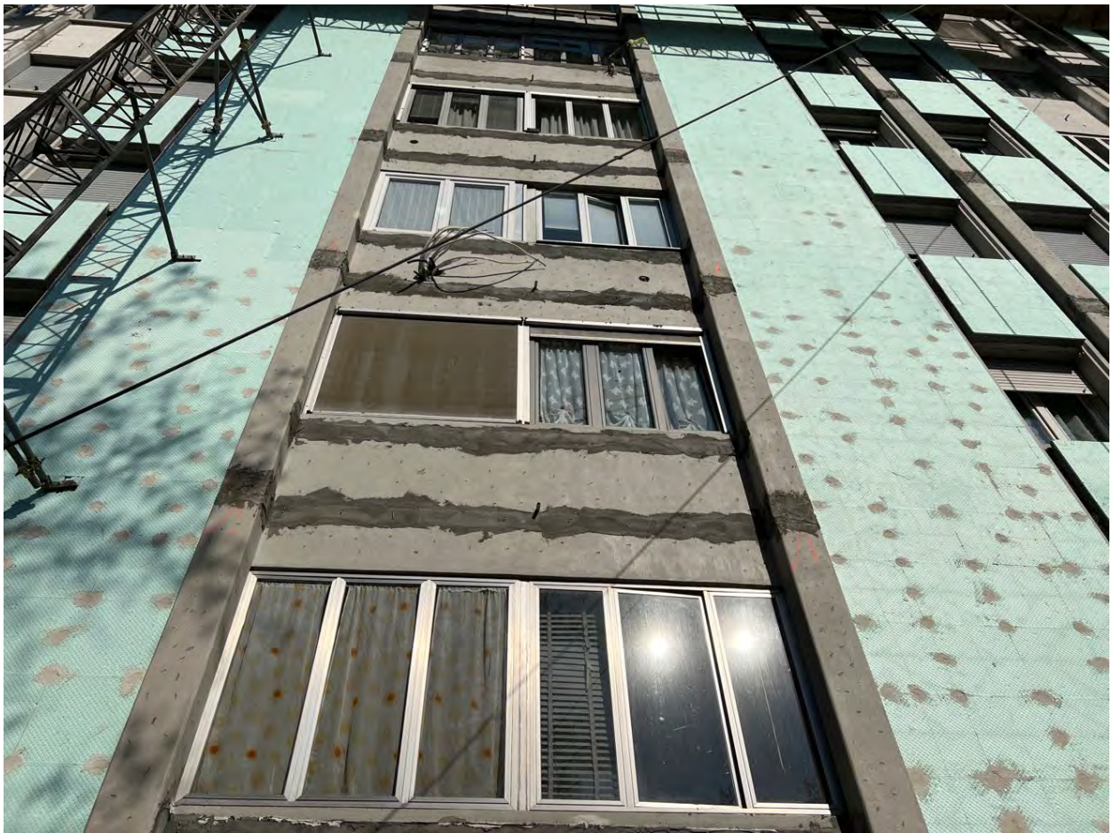
Fig.81 CA_1: Sopra, confronto tra il prospetto nord dell'edificio in linea a 10 piani e rilevazione termografica passiva del medesimo prospetto. Sotto, documentazione fotografica di cantiere; isolamento pareti esterne con EPS con grafite, schema tasselli a T. In corrispondenza delle fasce verticali di finestre, tra le aperture, è stato applicato lo stesso tipo di isolante.
