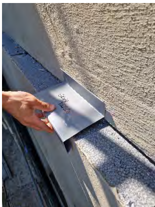
Fig.51 Documentazione fotografica di cantiere. MCA_2: prova colore della scossalina metallica di chiusura del perimetro superiore del cappotto esterno.
