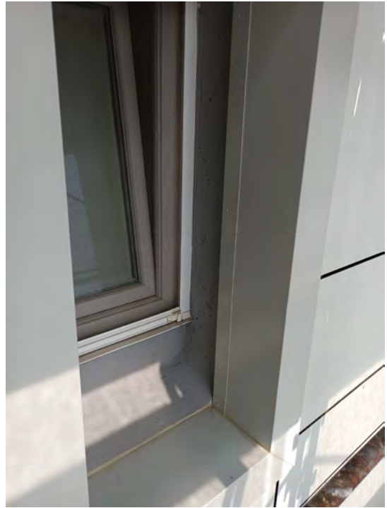
Fig.49 Da sinistra, particolare della parete ventilata, isolata con pannelli semirigidi in lana minerale, in corrispondenza degli infissi con aperture irregolari: la cornice in calcestruzzo non risulta raccordata né con lo strato isolante della parete né con la cornice metallica di finitura. Il ponte termico risulta pertanto non eliminato.
