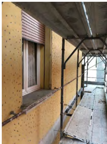
Fig.6 Documentazione fotografica di cantiere. M_8: documentazione di cantiere, preparazione del supporto murario.
