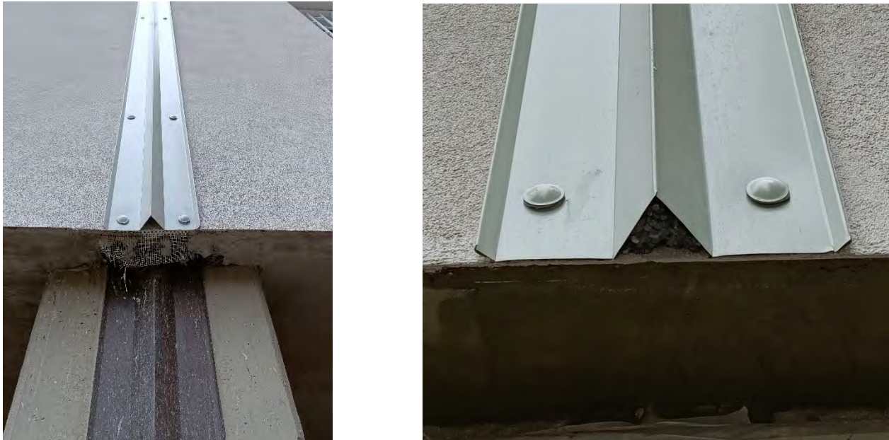
Fig.52 CA_11: Documentazione fotografica di fine lavori. Il giunto strutturale è stato coperto da rispettivo giunto di dilatazione del sistema ETICS; all'interno della cavità strutturale è stato inserito del materiale isolante.
