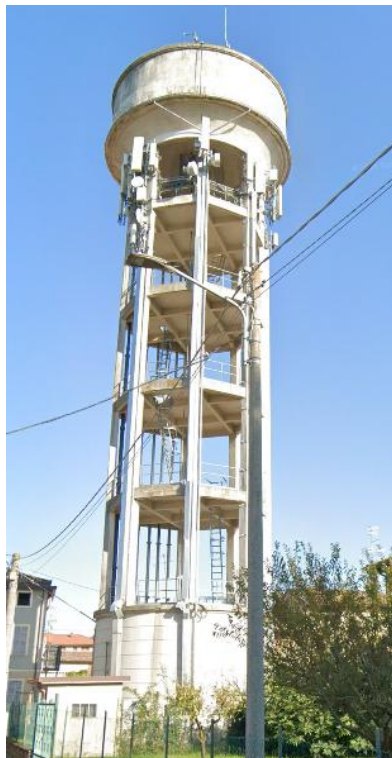
Figura 4: Esempio di serbatoio con vasca ottagonale - Serbatoio pensile di Montecchio (RE)
