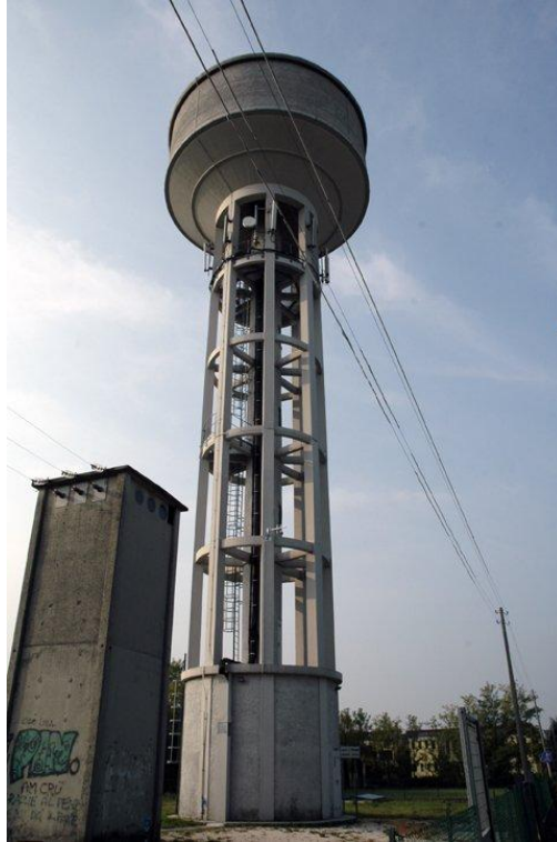
Figura 3: Esempio di serbatoio con vasca circolare - Acquedotto di Trevignano (TV)
