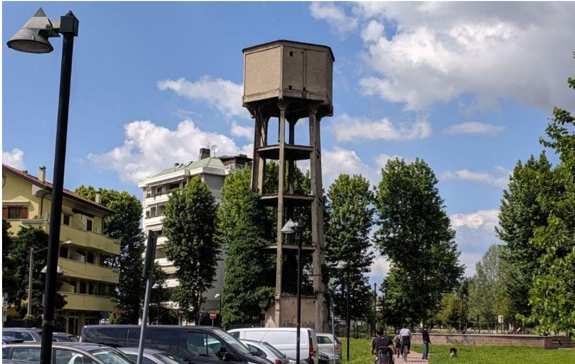
Figura 2: Esempio di serbatoio con vasca rettangolare - Serbatoio di Caronno Pertusella (VA)
