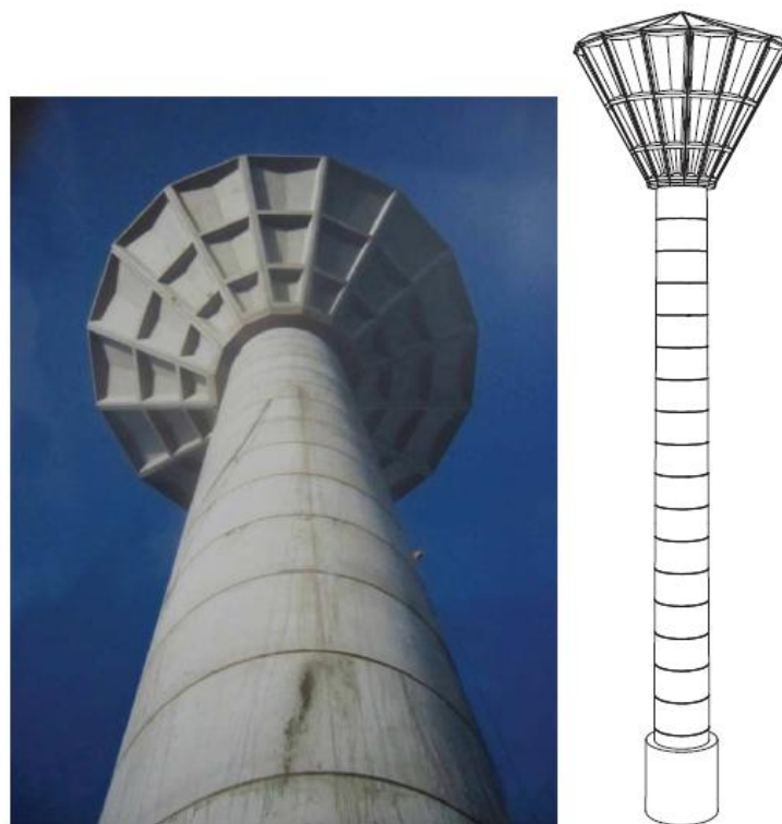
Figura 6: Esempio di serbatoio tronco-conico
