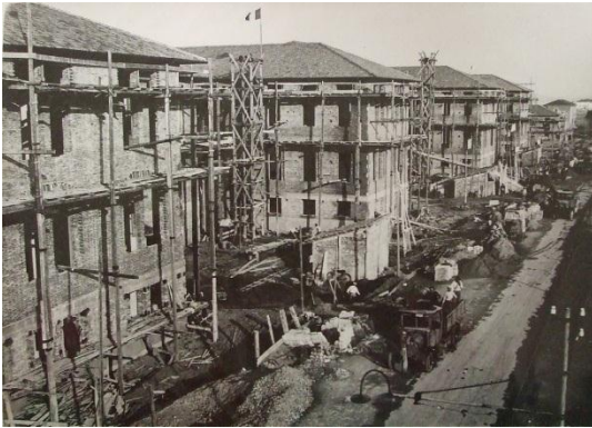
Fig.3 Lavori in corso.
