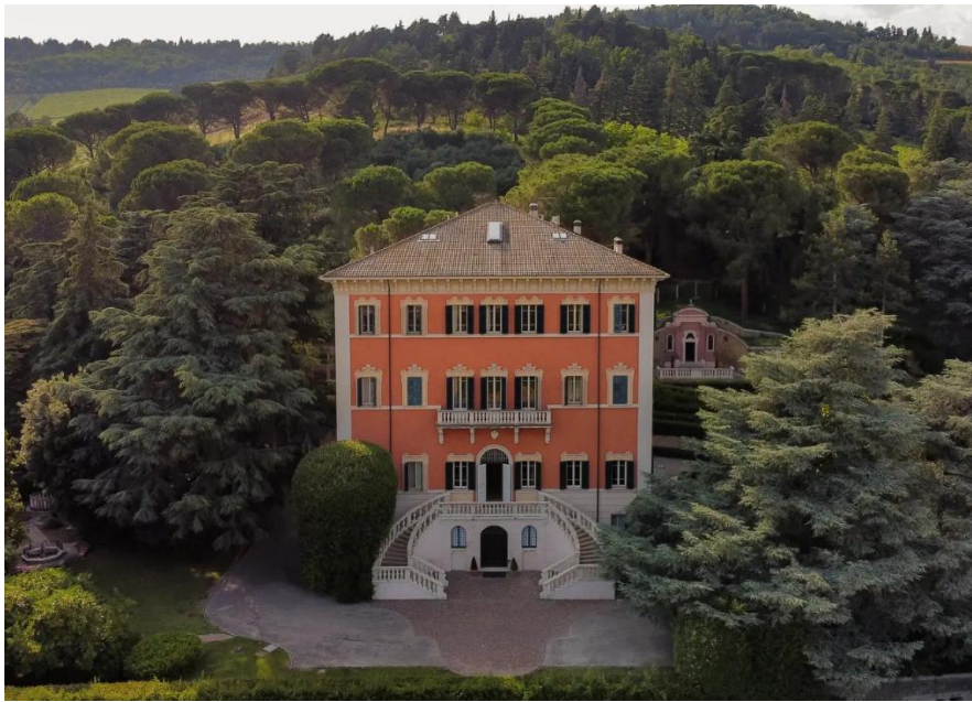
Figura 20, vista frontale della villa
