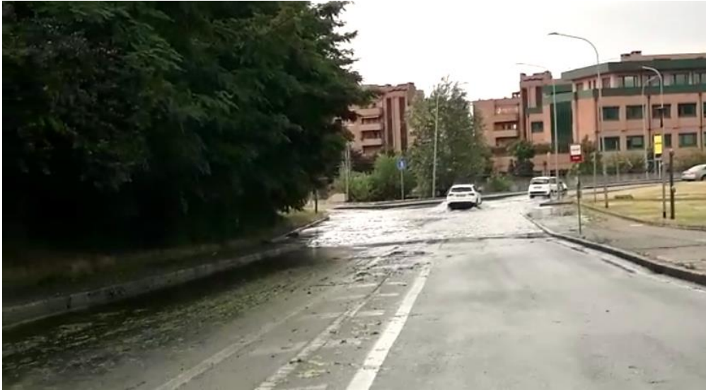
Figura 8 Allagamento Via Nenni in seguito a forte precipitazione, giugno 2019
