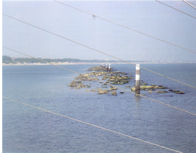
Figura 2.2: Barriera artificiale semi- sommersa situata nel sito di Cesenatico
