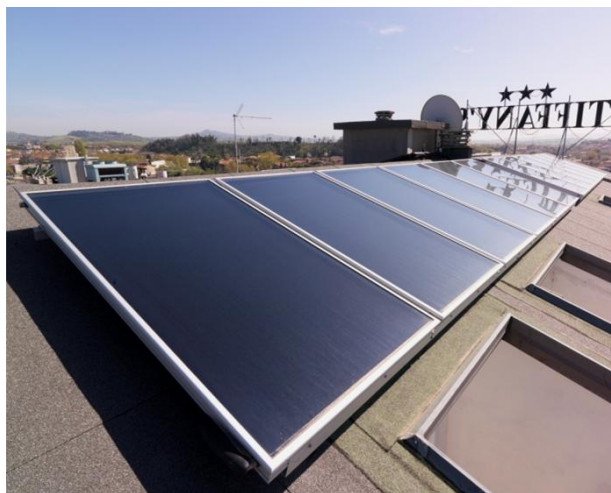
Figura 8 - Hotel Tiffany's (vista collettori lato Ovest)
