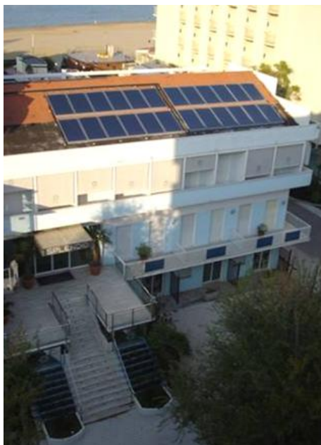
Figura 3 - Hotel Splendid (facciata Sud)
