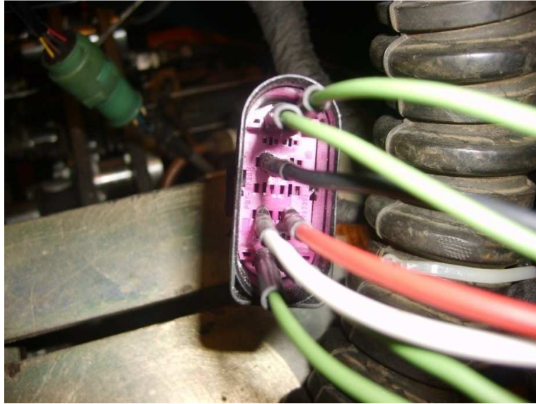
Figura 2.28 Connettore controllo pompa acqua
