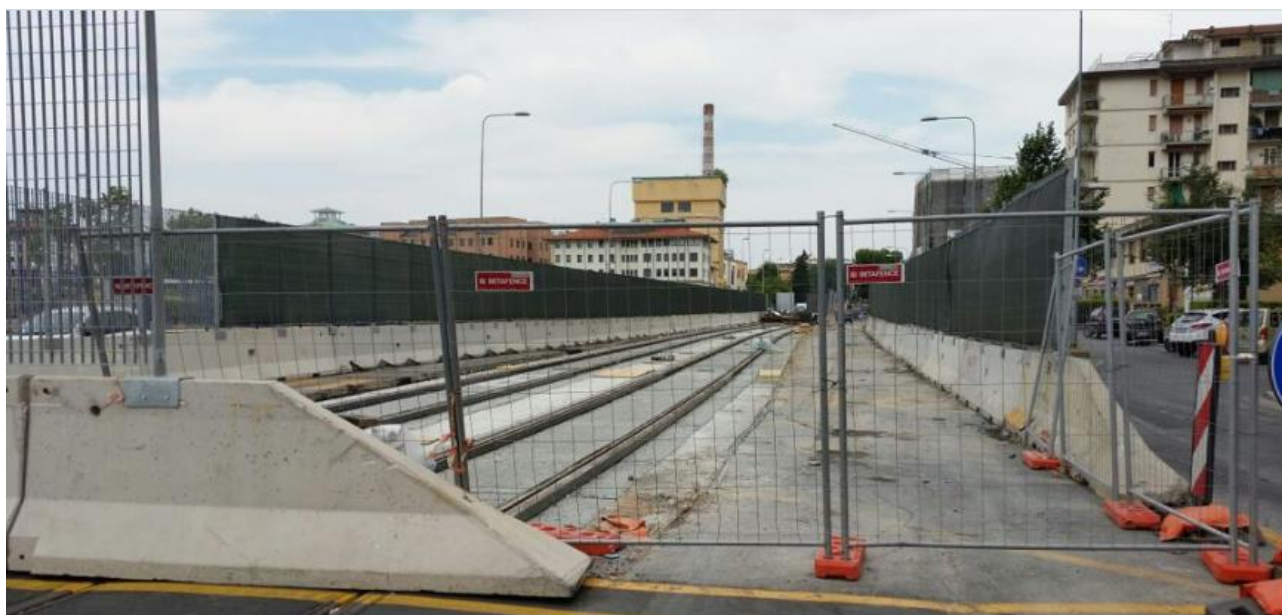
Fig. 36 Foto dei due tipi di recinzione utilizzati nel cantiere D2
