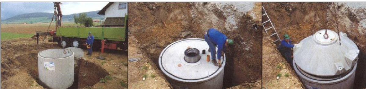
Figura 3.20- Installazione di una cisterna da 8,3 m 3
