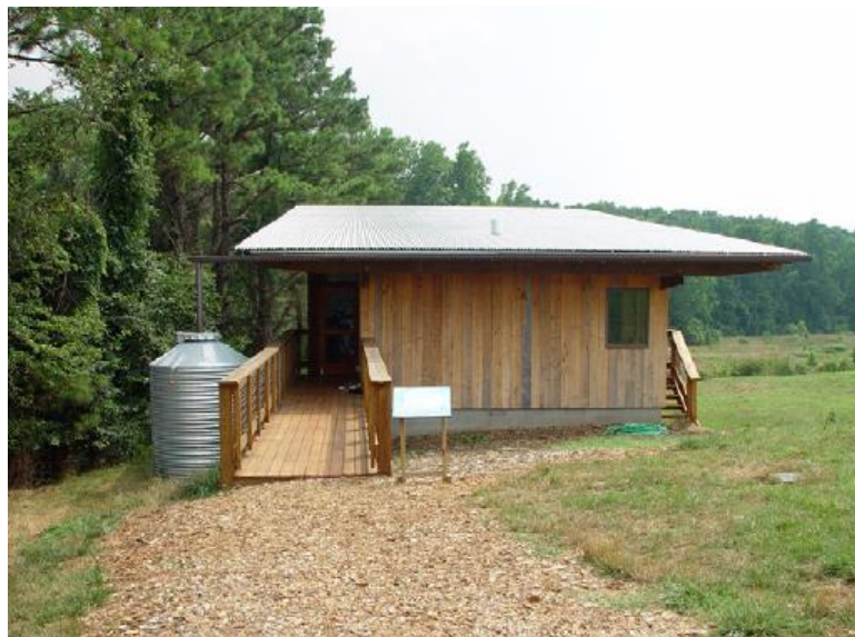
Figura 4.34- Sistema di raccolta dell'acqua piovana a Raleigh (Jones, Hunt, 2009)
