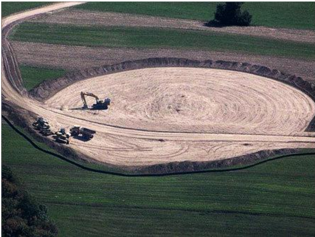
Fig.3: Altro scavo per basamento di una centrale eolica.
