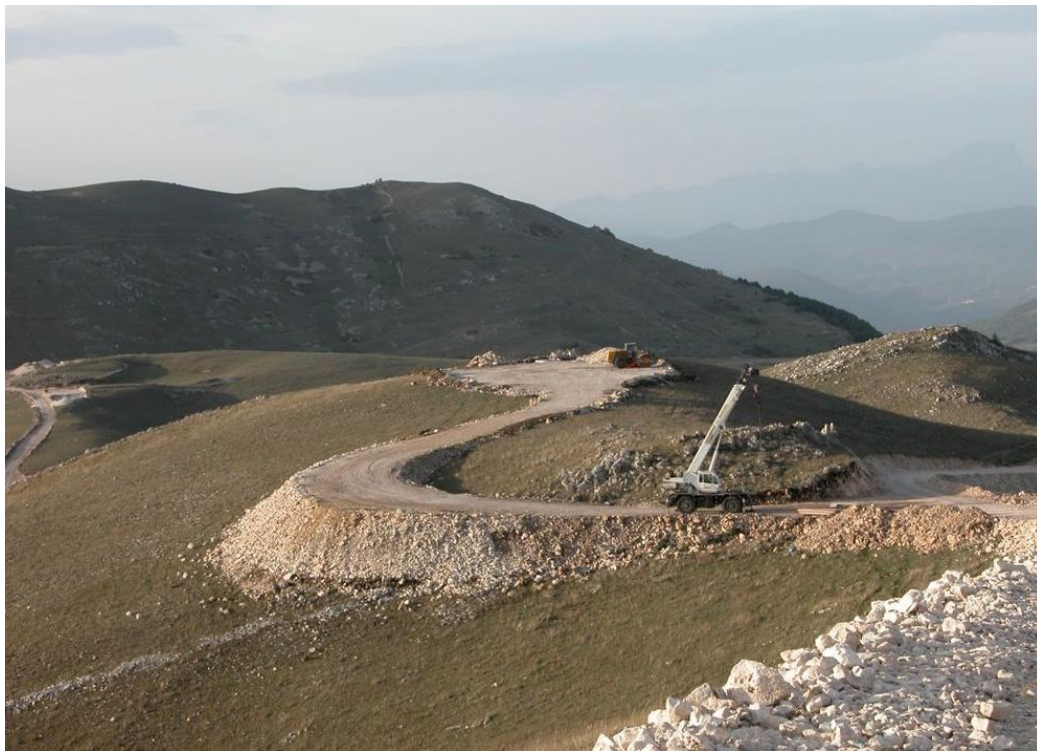
Fig.1: Lavori ausiliari relativi ad una centrale eolica in zona montuosa in Abruzzo
