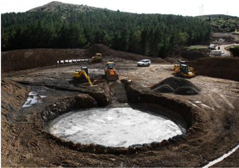
Fig. 2: Scavo per basamento di una centrale eolica
