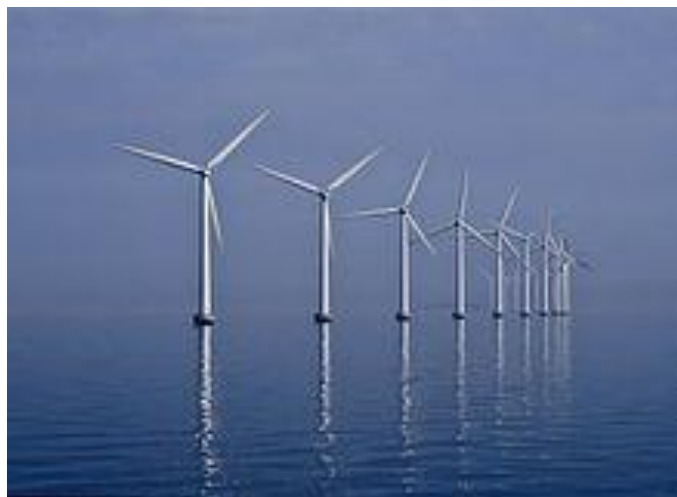
Fig. 2.1.4: Impianto eolico off-shore da 40 MW nello stretto di Oresund al largo di Copenaghen
