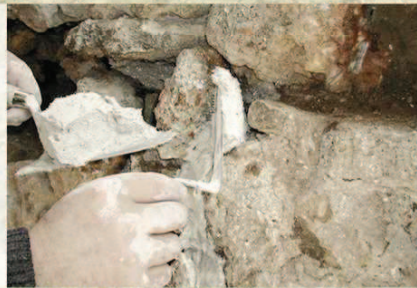
Dettaglio immagine di stuccatura con calce idraulica naturale.
