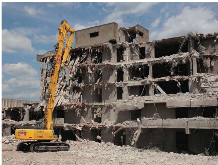
Fig.22: Demolizione di un edificio
