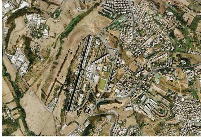
Fig.16: Nuovo Corviale: veduta dell'insediamento
