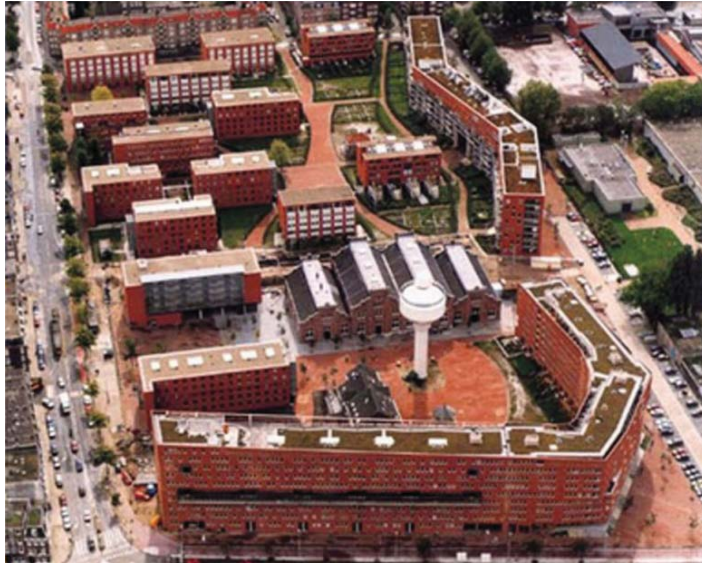
Fig.19: GWL Terrein, vista del quartiere
