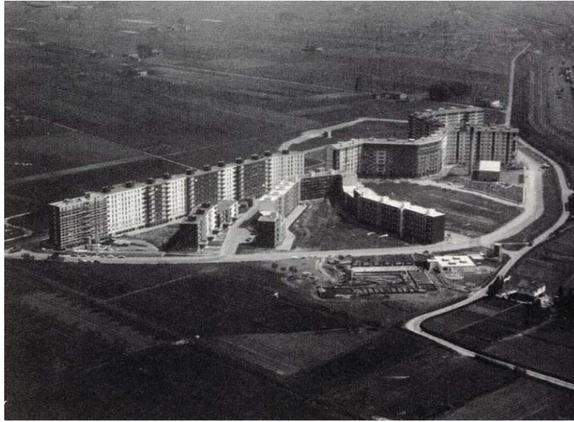
Fig.11: Primo insediamento del Pilastro
