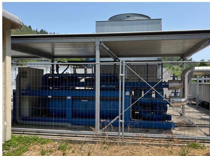
**Fig. 3.3.1: gruppo frigorifero all'esterno della struttura del laboratorio CICLoPE**
