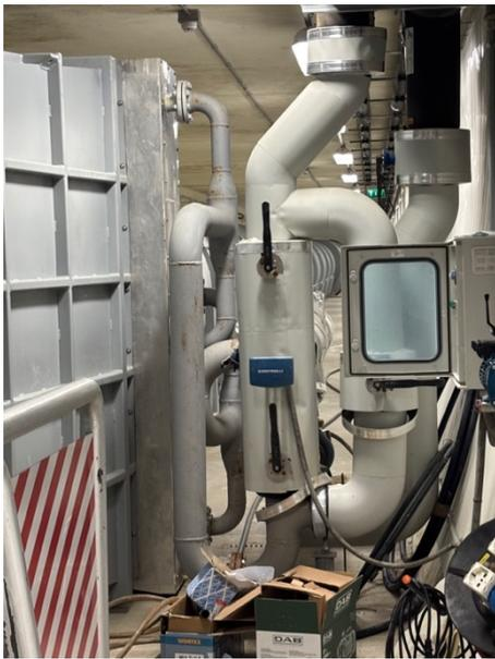
**Fig. 3.3.2: gruppo di ricircolo del refrigerante con valvola di regolazione del flusso e scambiatore di calore sulla sinistra**
