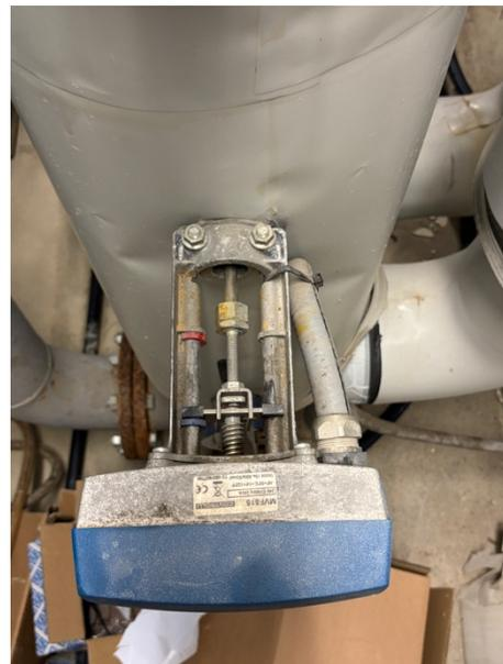
**Fig. 3.3.3: dettaglio valvola deviatrice del flusso refrigerante**
