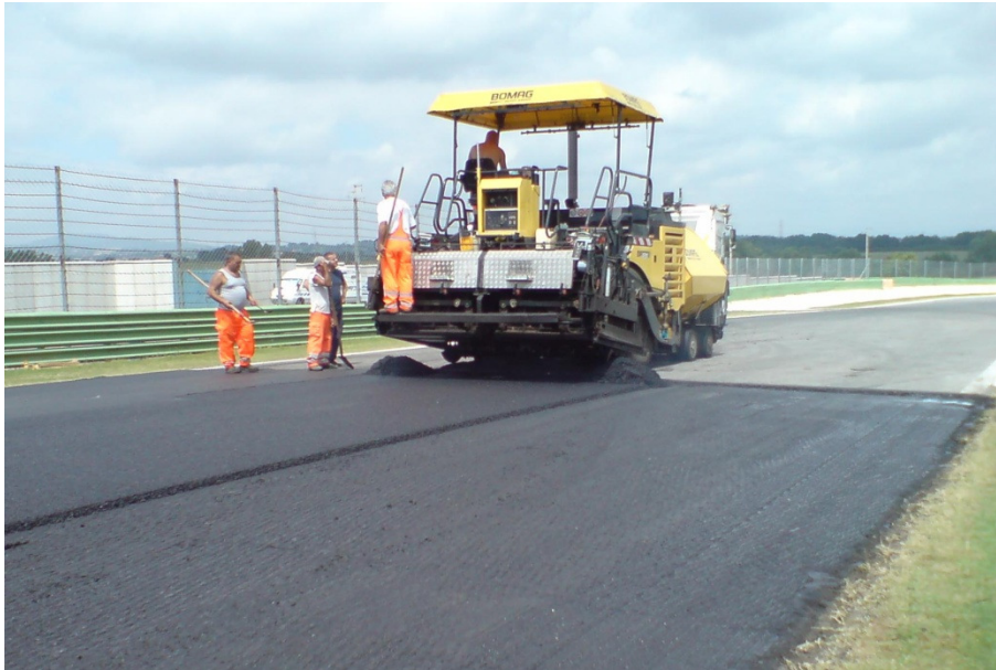
Figura 1.14 –Stesa conglomerato bituminoso autodromo Imola
