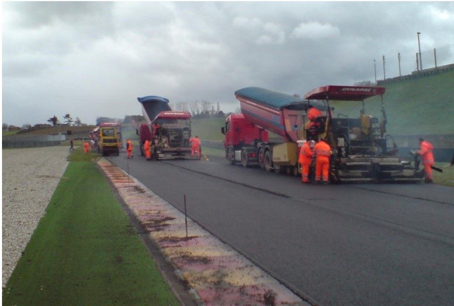
Figura 1.16 –Stesa conglomerato bituminoso autodromo Mugello
