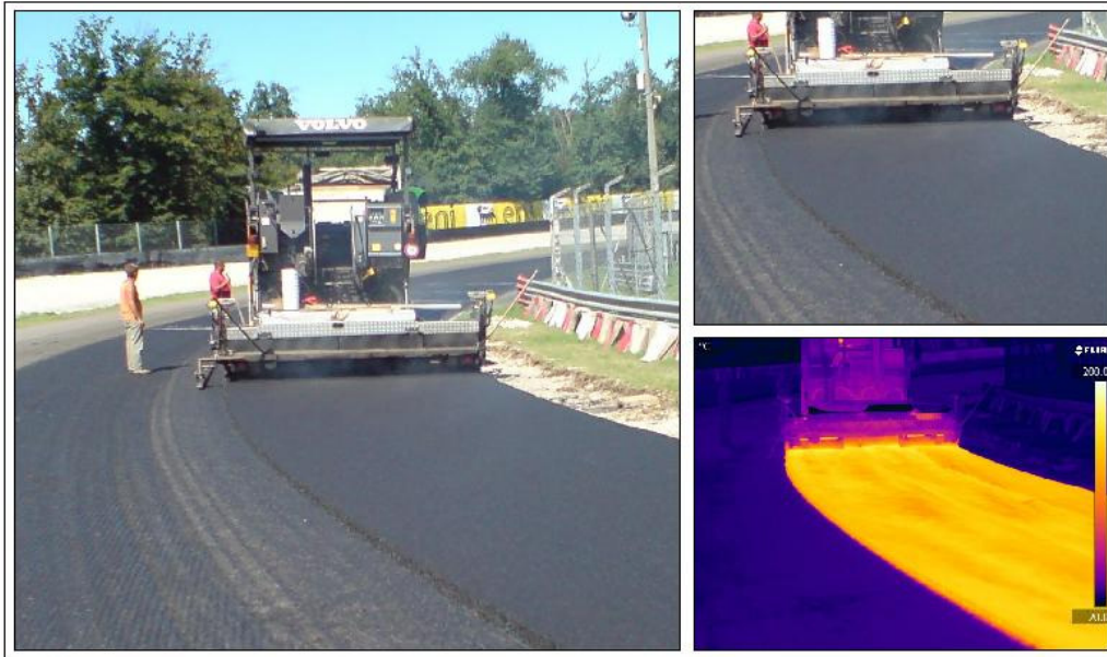
Figura 3.19: Foto termica durante la stesura del conglomerato bituminoso a Monza
