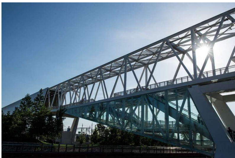
Figura 1.7: Passerella “PEM” - EXPO2015; vista laterale
