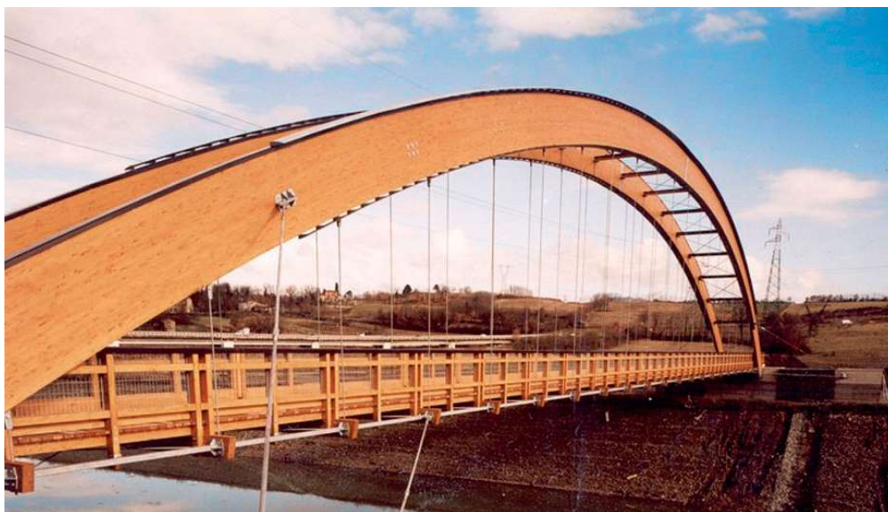
Figura 1.12: Passerella ciclopedonale Barberino del Mugello – vista laterale
