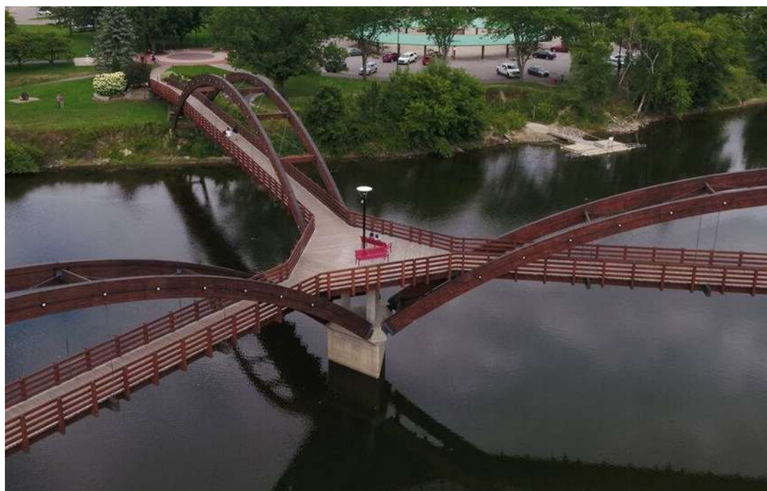
Figura 1.14: Passerella pedonale a tre vie, "The Tridge" – struttura in legno ad arco
