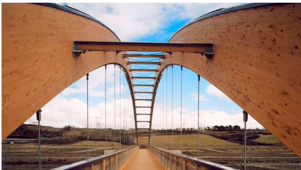
Figura 1.13: Passerella ciclopedonale Barberino del Mugello – struttura in legno
