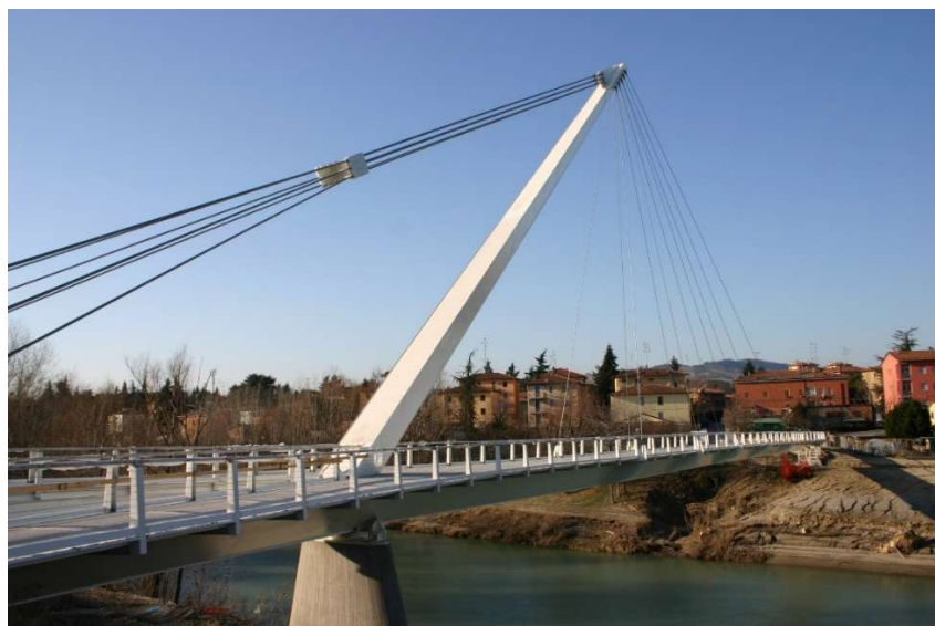
Figura 1.18: Passerella ciclopedonale strallata - Casalecchio di Reno (BO)
