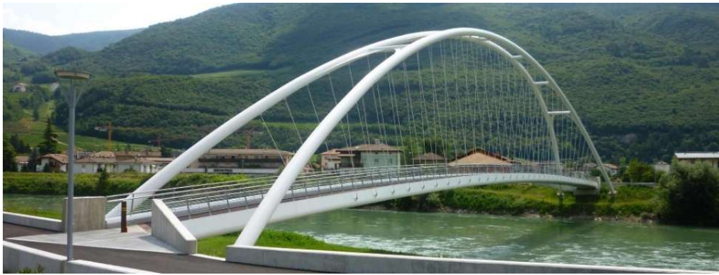
Figura 1.10: Ponte ciclopedonale San Michele all'Adige - struttura ad arco
