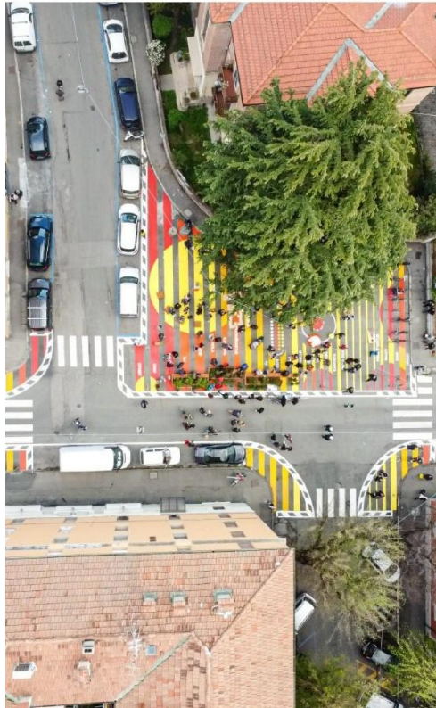
Figura 47: Immagine ottenuta da un drone una volta conclusi i lavori [48]
