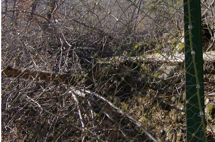
Figura 44 - Carenze in seguito ad evento : riempimento vegetativo
