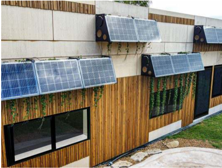
FIGURA 16: Fioriere fotovoltaiche in un caso studio a Barcellona (Fonte: www.Drive0.eu )
