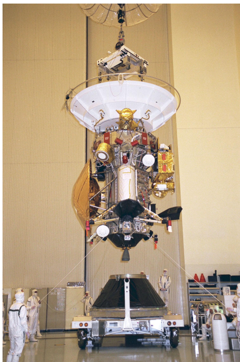
Figura 2.6: Cassini viene posizionata sull'adattatore per il sistema di lancio, il quale verrà successivamente collegato al lanciatore. Crediti: NASA/JPL-Caltech
